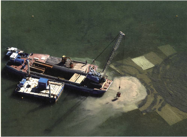
Rapperswil-Jona, Technikum. Luftaufnahme der Schutzmassnahmen. Foto KASG.
