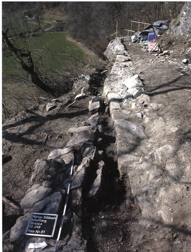
Wartau SG, Alte Schollbergstrasse. Wegstrecke bei der exponierten Stelle an der Hohwand: Eine Stützmauer (rechts im Bild) sichert die Strasse an der steil abfallenden Felskante (ganz hinten im Bild).
