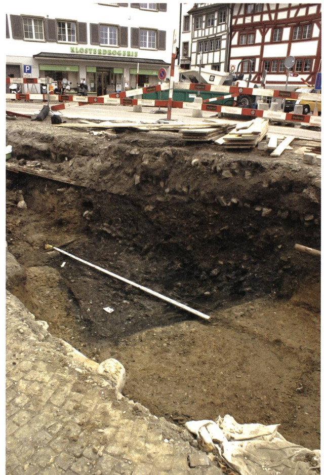
St. Gallen, Gallusstrasse, Höhe Stiftsbibliothek. Rechteckige Latrine (wiederverwendeter Keller?) mit Bretterverschalung. Nach Auflassung im 13. Jahrhundert aufgefüllt mit Brandschutt. Foto KASG.
