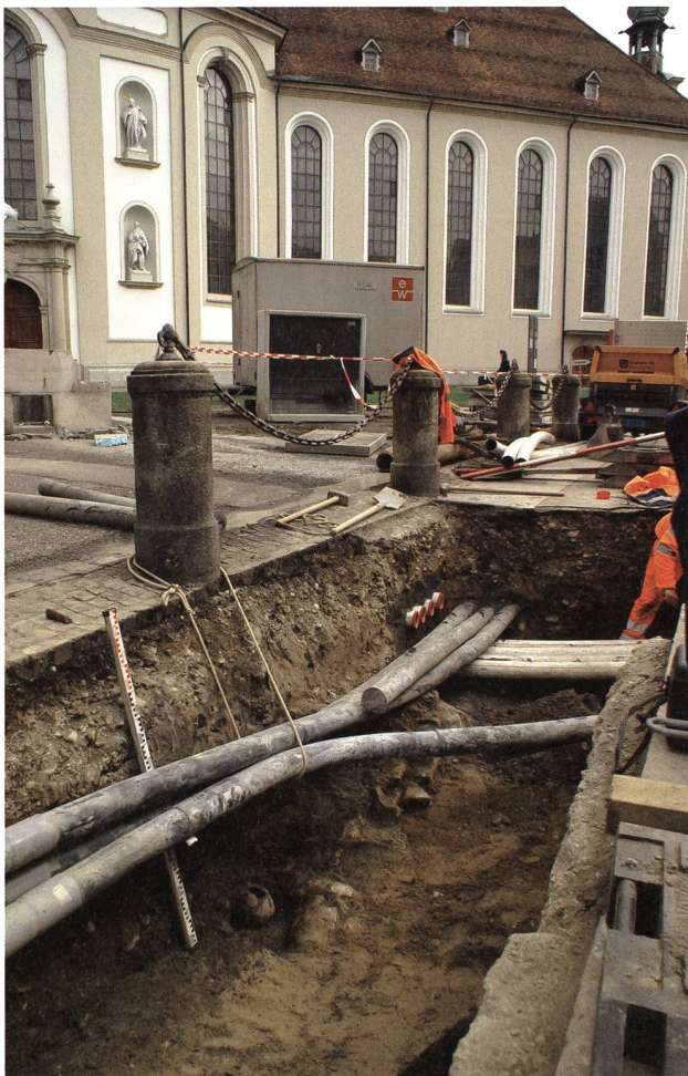
St. Gallen, vor Klosterhof 5. Angeschchnittenes Grab Pos. 326 im Leitungsraben. Foto KASG.
