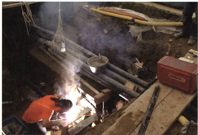
St. Gallen, Klosterhof. Sämi Bischof beim Schweiessen der Trägerkonstruktion. Foto KASG.
