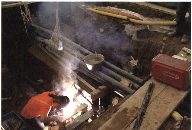
St. Gallen, Klosterhof. Sämi Bischof beim Schweißen der Trägerkonstruktion. Foto KASG.
