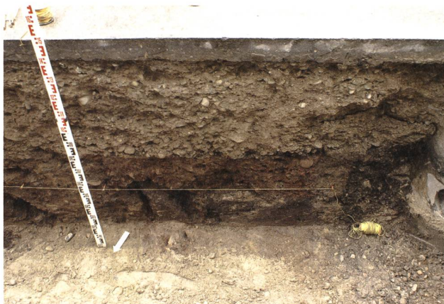
St.Gallen, Schmiedgasse 2009. Vom Schlackenrost verkitteter und rot gefärbter Strassenkoffer zeugt vom namengebenden Schmiedegewerbe. Foto KA SG.
