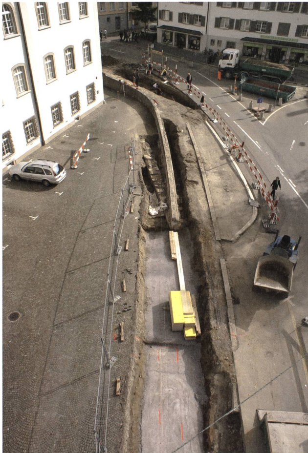
St. Gallen, Ostseite Gallusplatz/St. Georgenstrasse 2010. Blick auf die Baustelle der neuen Brüstungsmauer. Unterhalb der Betonfundamente liegen nur noch wenige archäologische Reste. Foto KA SG.
