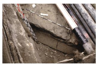
St. Gallen, Grünturm. 2010 Ansicht des Fundamentsockels aus grossen, sorgfältig zugerichteten Sandsteinblöcken. Foto KA SG.
