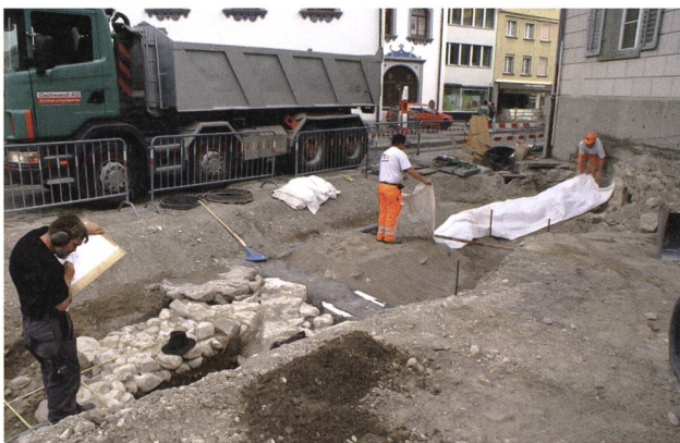
St.Gallen, 2009. Im Bereich Klosterhof/Gallusstrasse können die Fundamente der Schiedmauer erhalten und geschützt werden. Foto KA SG.
