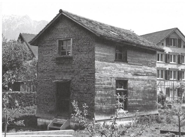
HHVW als Besitzerin: Die Messerschmiede Roth – in der Schweiz ein einmaliges Relikt aus dem letzten Jahrhundert – soll nun von Buchs nach Grabs versetzt, restauriert, betrieben und für Besucher zugänglich gemacht werden (Foto: Hansruedi Rohrer).
