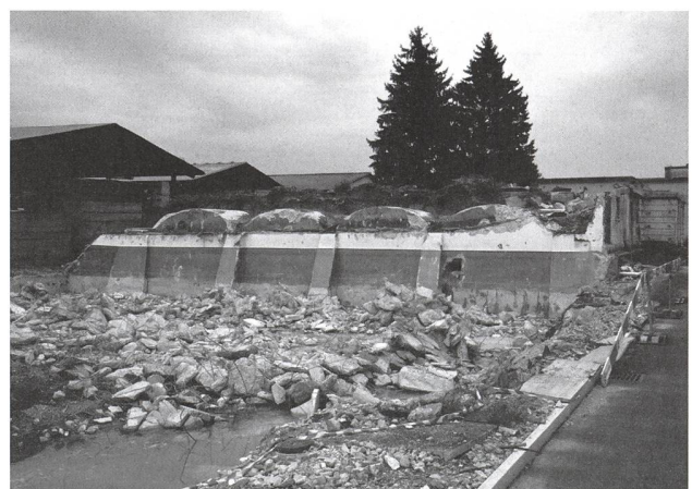
Filterhalle der St. Galler Stadtwerke in Goldach. Robert Maillarts innovative Betonkonstruktion nach hundert Jahren vom Bagger zerstört (Foto: kant. Dpfl).
