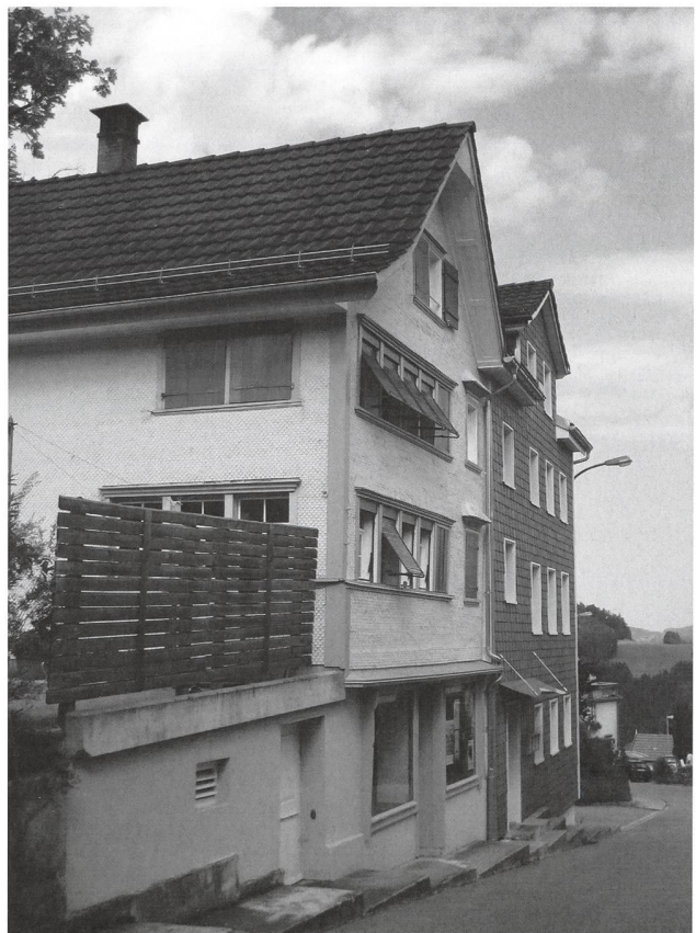
Lebendigkeit eines gestrichenen Holzschindelschirms neben einer zu Tode sanierten Eternitfassade in Mogelsberg (Foto: kant. Dpfl).
