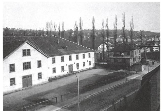
Kavalleriekaserne an der Steinachstrasse, um 1905, als sie noch als Absonderungshaus diente. Sie wurde 1856/57 gebaut und 1931 abgerissen. Heute steht hier das Athletik Zentrum (Stadtarchiv St.Gallen, OGA Tab/Ph,313).
