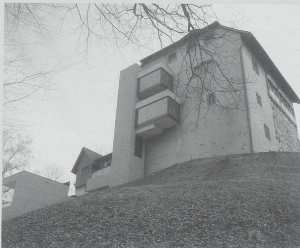
Der neue Aussenlift mit den zwei Glas-Passerellen an der Nordseite vom Schloss Oberberg in Gossau.
