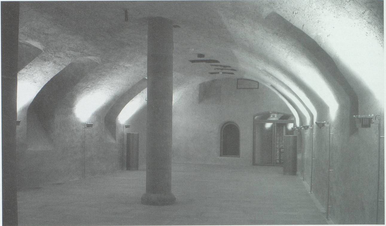
Hof zu Wil, der soeben fertig restaurierte Gewölbekeller (Foto: Affolter & Kempfer Architekten).
