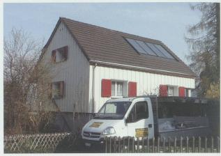
Balgach. Beim einen Beispiel (ganz oben) wurde die Einfassung nicht der Kollektorenfarbe angeglichen, sondern in heller Farbe erstellt. Dies führt dazu, dass sie wegen des Kontrastes optisch zu stark in Erscheinung treten. So scheint es, dass sie nicht dachbündig sind, sondern über das Dach hinaus stehen, ganz im Gegensatz zum unteren Beispiel (Fotos: kant. Denkmalpflege).
