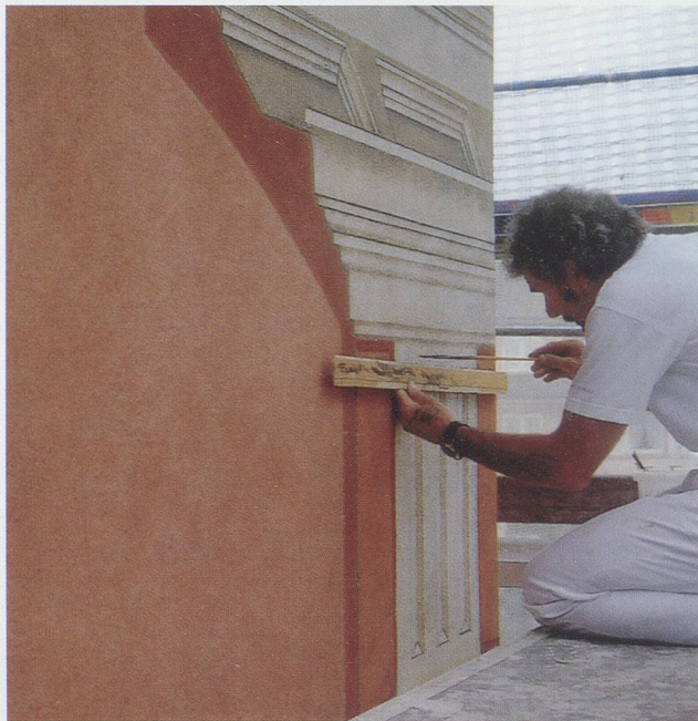
Der «Alte Sternen» in Rapperswil, Engelplatz 2, wird 1568 als Teil der östlichen Stadtbefestigung erbaut und 1790 nach dem Zeitgeschmack barockisiert. Der als Stadtpalast ausgebildete Bau zeigt einen lachsroten Verputz mit aufgemalten Eckpilastern, Fenstereinfassungen und Verdachungen in barockem Gepräge. 1966/67 wurden die Reste der barocken Illusionsmalerei von Eugen Müller, Flawil, rekonstruiert und restauriert. 2007 wurde die Bemalung mit einer Zweikomponenten-Mineralfarbe (Keim) ausgebessert und mit einer dünnen Farbschicht in Schwammtechnik gefestigt. (Fotos: Fontana & Fontana AG, Jona).
