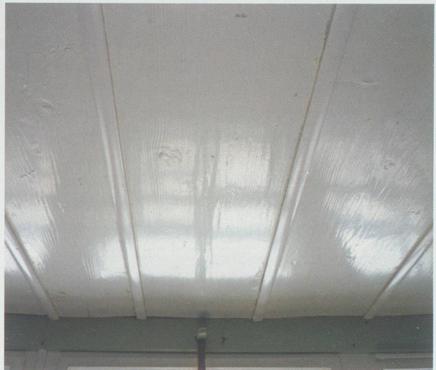
Ein Beispiel für die unterschiedliche Struktur, die Pinsel und Roller zurücklassen. Oben eine Decke aus Dielenbrettern mit dem Roller gestrichen, die Spuren der Fasern bewirken ein unruhiges Bild. Unten eine gleichartige Decke, mit dem Pinsel gestrichen, die einen matten Glanz aufweist (Fotos: kant. Denkmalpflege).
