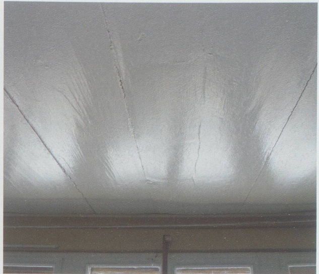
Ein Beispiel für die unterschiedliche Struktur, die Pinsel und Roller zurücklassen. Oben eine Decke aus Dielenbrettern mit dem Roller gestrichen, die Spuren der Fasern bewirken ein unruhiges Bild. Unten eine gleichartige Decke, mit dem Pinsel gestrichen, die einen matten Glanz aufweist (Fotos: kant. Denkmalpflege).
