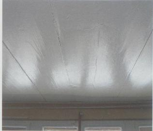
Ein Besipiel für die unterschiedliche Struktur, die Pinsel und Roller zurücklassen. Oben eine Decke aus Dielenbrettern mit dem Roller gestrichen, die Spuren der Fasern bewirken ein unruhiges Bild. Unten eine gleichartige Decke, mit dem Pinsel gestrichen, die einen matten Glanz aufweist (Fotos: kant. Denkmalpflege).
