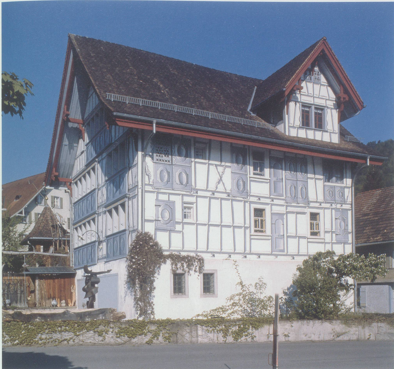
Berneck, Kirchgasse 8. Das grau gefasste Fachwerkhhaus aus dem 17. Jahrhundert zeigt eine Grisaille-Malerei mit aufgemalten Fenstern und Türen (Foto: kant. Denkmalpflege).
