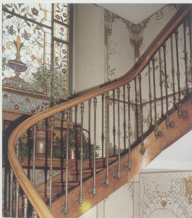
Rapperswil, Curti-Haus, Treppenhaus mit floraler Dekorationsmalerei, geschwungenem Treppenlauf mit gusseisernen Staketen und kunstvollem Glasmosaik aus gewelltem Opakglas, dessen farbiges Gespinst mit Blüten und Ranken zusammen mit den eleganten Verbleiungen bereits einen Hauch von Jugendstil verströmt. Die grau gemalten Fensterrahmen lassen die Farben leuchten. (Foto: kant. Denkmalpflege).
