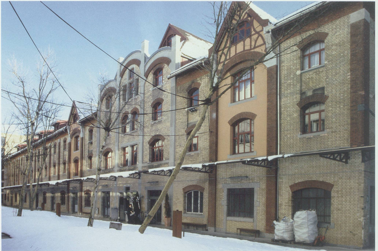
St.Gallen, Lagerhaus, Ansicht der Südfassade (Foto: kant. Denkmalpflege).
