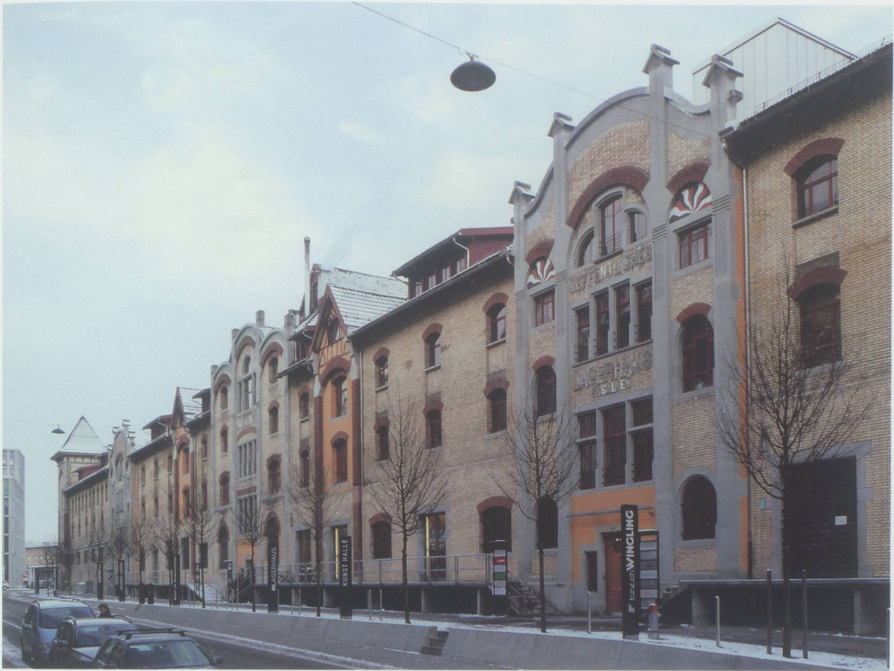
St.Gallen, Lagerhaus, Ansicht der Seite Davidstrasse (Foto: kant. Denkmalpflege).
