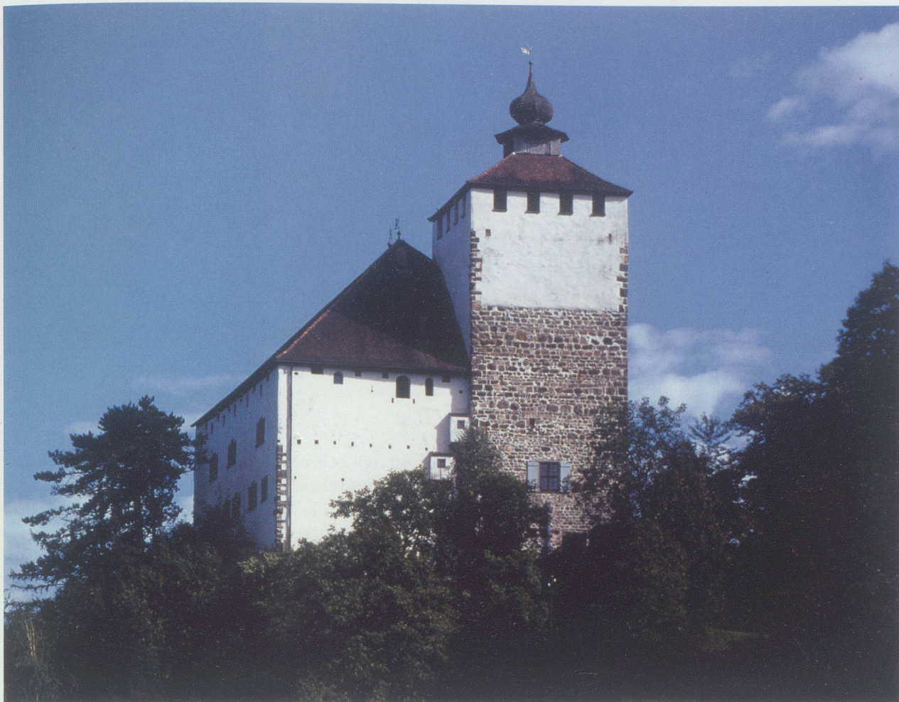
Grabs, Ansicht des Schlosses Werdenberg von Norden (Foto: kant. Denkmalpflege).
