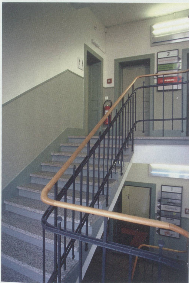
St.Gallen, Lagerhaus, Treppenhaus (Foto: kant. Denkmalpflege).
