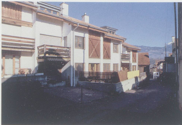
Azmoos (Gemeinde Wartau), gelungene, kleinteilige Neubauzeile im engen historischen Gassengewirr des Bergdorfes (Foto: kant. Denkmalpflege).
