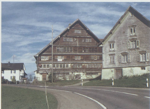
Waldkirch, Rickenhieb. Einer der grössten Strickbauten des Kantons (ein Schutzobjekt) steht einer Strassenbegradigung im Weg und es bestehen Bestrebungen zum Abbruch – und dies nachdem eine vom Kanton geplante Umfahrung von den Einwohnern erfolgreich bekämpft worden ist! (Foto: kant. Denkmalpflege)
