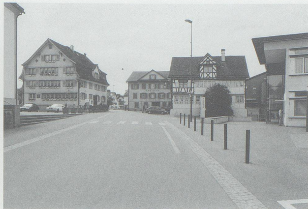
Mörschwil. Mit dem geplanten Abbruch des Gasthauses Freihof (Bildmitte) hätte sich der geschlossene Kirchplatz in seine Einzelbestandteile aufgelöst (Foto: kant. Denkmalpflege).
