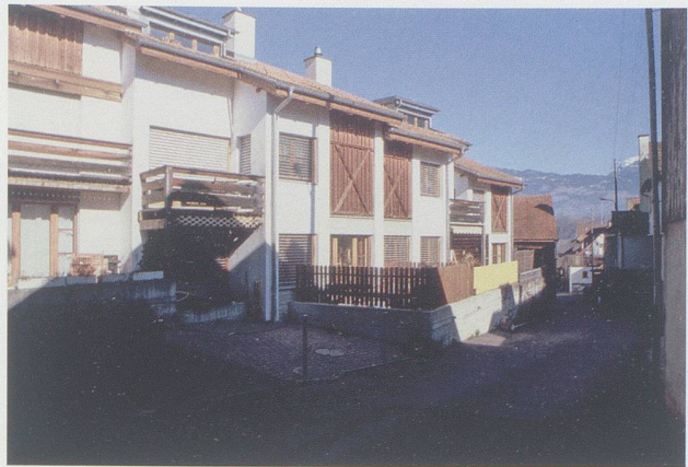
Azmoos (Gemeinde Wartau), gelungene, kleinteilige Neubauzeile im engen historischen Gassengewirr des Bergdorfes (Foto: kant. Denkmalpflege).
