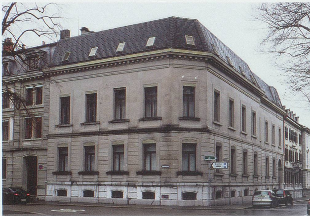
St. Gallen, Museumstrasse. Das Kirchoferhaus wurde 1965 fast seiner ganzen Zierelemente beraubt und steht nun gleichsam ohne Kleider da (Foto: kant. Denkmalpflege).
