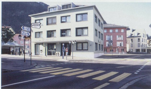
Bad Ragaz, Bartholoméplatz. Die Einfahrt zur Tiefgarage und die Häuserzeile Kantonalbank – Ochsen – Confiserie Fässler bilden eine Barriere zum dahinterliegenden alten Dorfkern (Foto: kant. Denkmalpflege).
