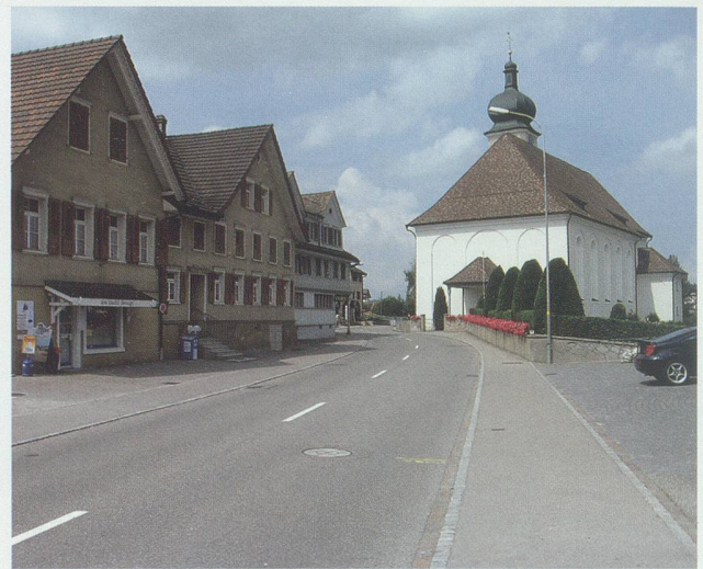
Niederhelfenschwil. In den 1930er-Jahren war die Dorfstrasse noch von Vorgärten gesäumt. Das Trottoir wurde erst 1979 erstellt. Vergangenes Jahr konnte durch die Zusammenarbeit von Gemeinde und Denkmalpflege gegenüber der Kirche ein Vorgarten in aktueller Gestaltung wieder hergestellt werden (Fotos: Politische Gemeinde Niederhelfenschwil).
