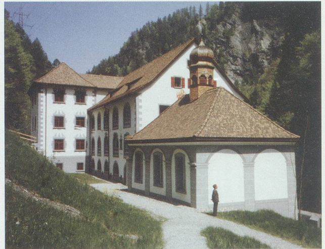
Das Alte Bad Pfäfers. Das Vorderhaus mit Kapelle, erbaut 1704–1718 nach einem Projekt von Andreas Metzenkopf, wurde nach dem Abbruch des Hinterhauses 1974 durch die Initiative privater Vereinigungen gerettet und 1983–1995 restauriert (Foto: kant. Denkmalpflege).
