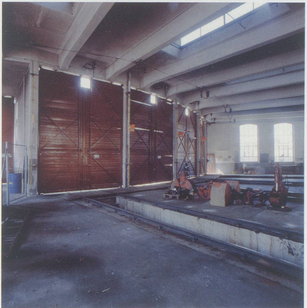
Die Lokremise Wil von 1911, vor kurzem noch vom Abbruch bedroht, darf nun einer kulturellen Nutzung entgegenblicken (Fotos: kant. Denkmalpflege).
