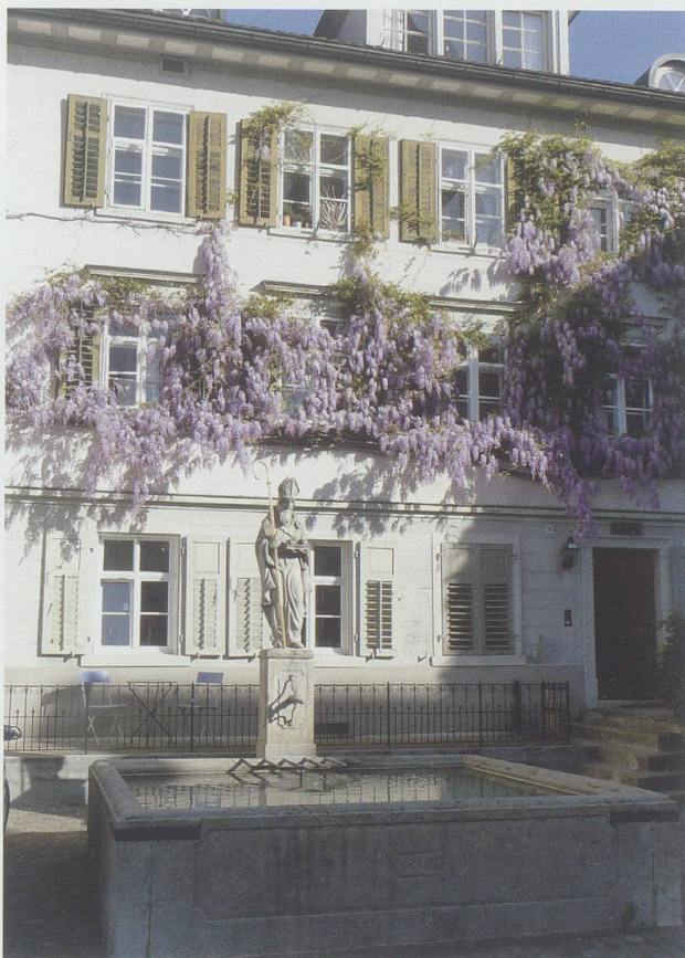
Ein romantischer Blick in die Wiler Kirchgasse (Foto: kant. Denkmalpflege).
