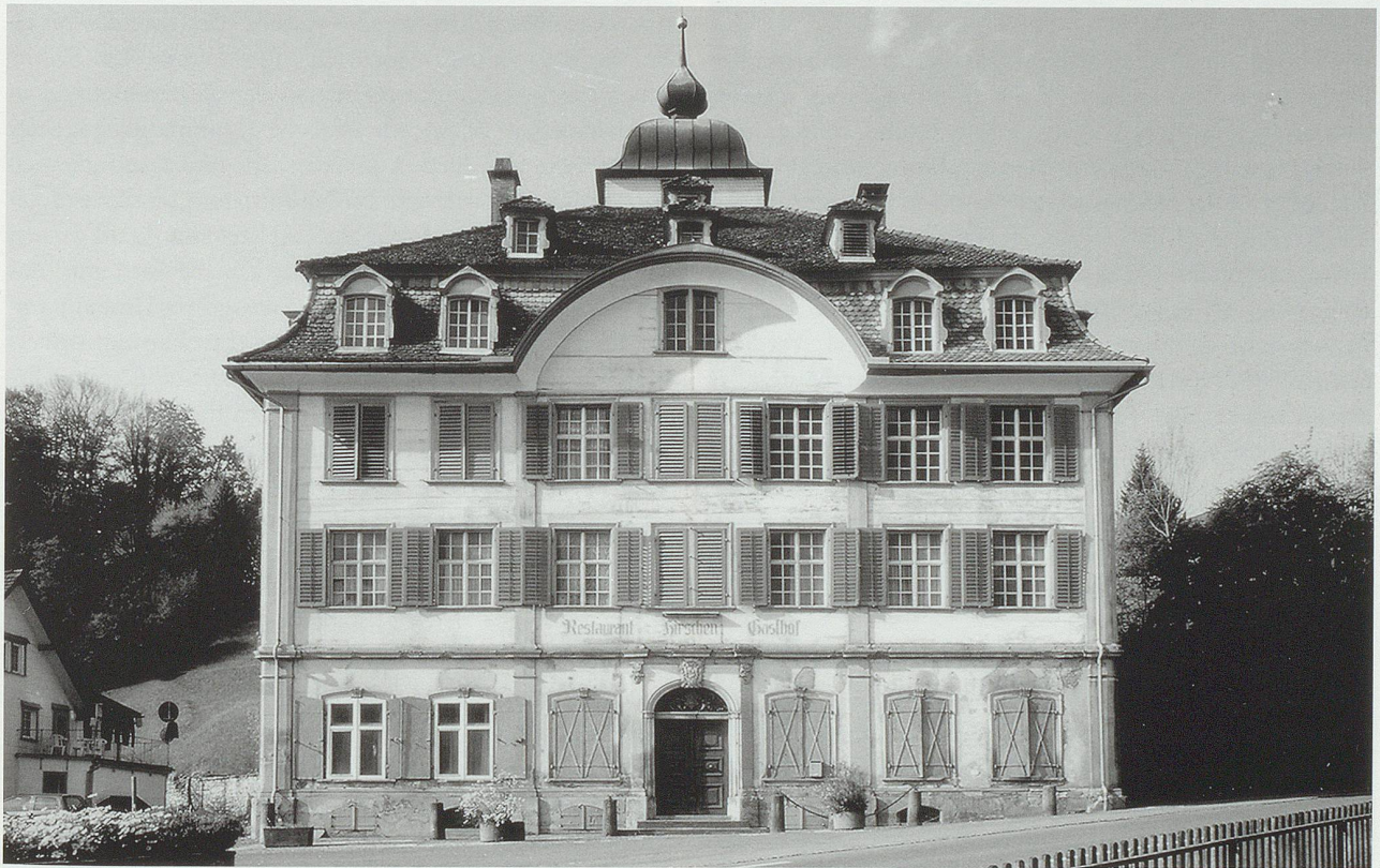
Gasthof Hirschen Oberglatt, Zustand 2007. (Bild kant. Denkmalpflege)
