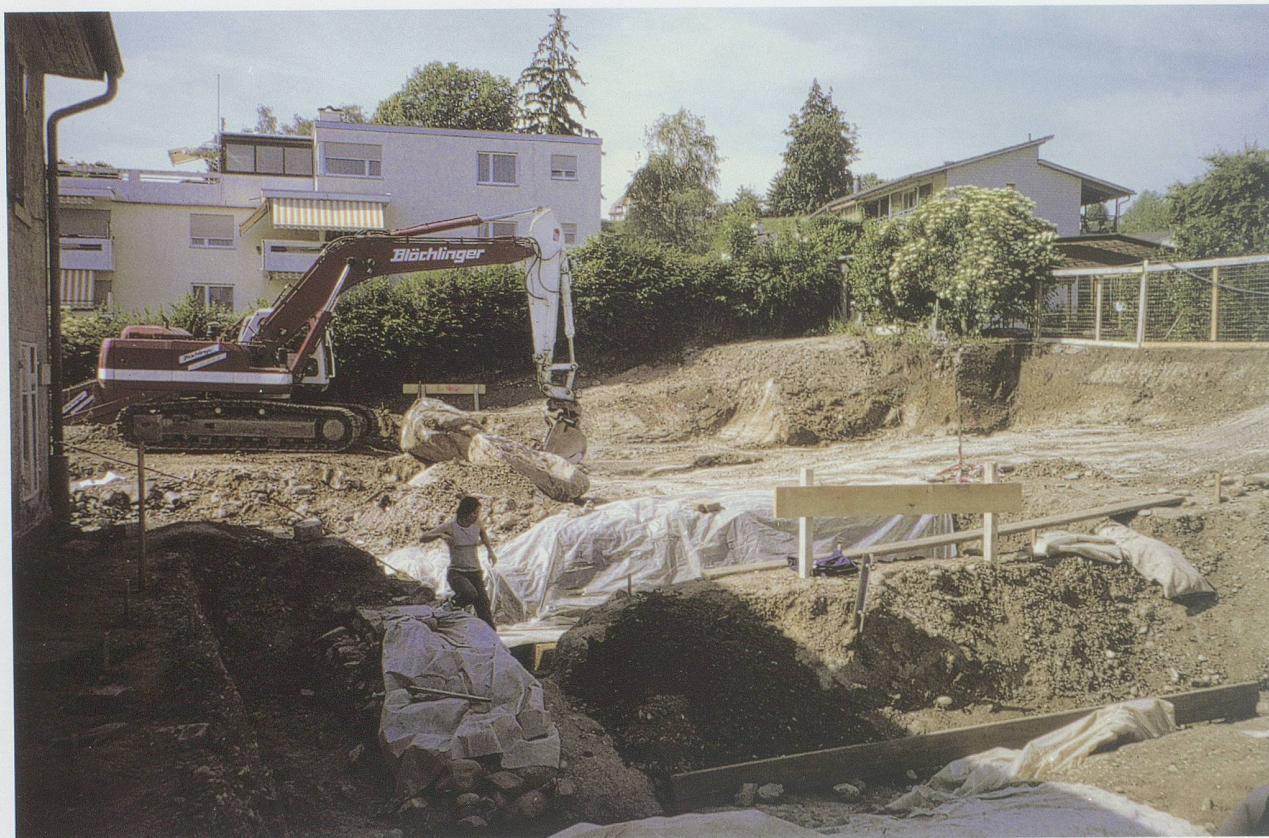
Abb. 25: Jona, Kempraten, Fluhstrasse 8/10. Zuerst Ausgrabung, dann Überbauung. (Bild KASG)
