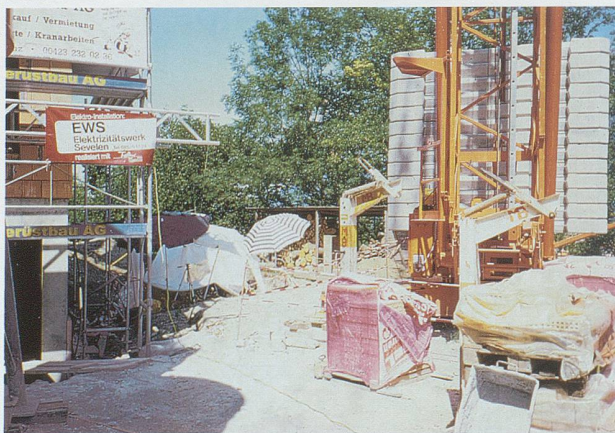
Abb. 15: Sevelen, Pfäfersbüel. Die Ausgrabung der bislang ältesten Bauernsiedlung im Kanton läuft parallel zu den Bauarbeiten. (Bild KASG)
