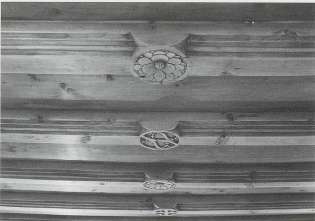
Abb. 11: Seit das im 12. Jh. gegründete Benediktinerkloster Alt St. Johann 1629 nach Sidwald verlegt worden war, diente die alte Anlage als Propstei. Hauptakzent des Umbaus von 2005/06 war die Schaffung eines Saals für die Kirchgemeinde im zweiten Stock. Ein überraschender Fund ist diese perfekt erhaltene Bohlen-Balkendecke von 1486 in der ehemaligen Abtswohnung. (Bild Philip Lehmann, St. Gallen)
