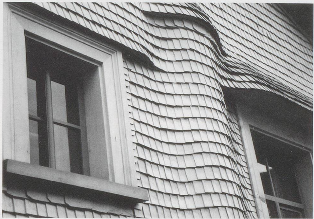
Abb. 13: Wie ein wärmender Mantel umgibt das neue handgespaltene Schindelkleid das Tätschdachhaus in Ennetbühl. (Bild Heinrich & Verena Scherrer)
