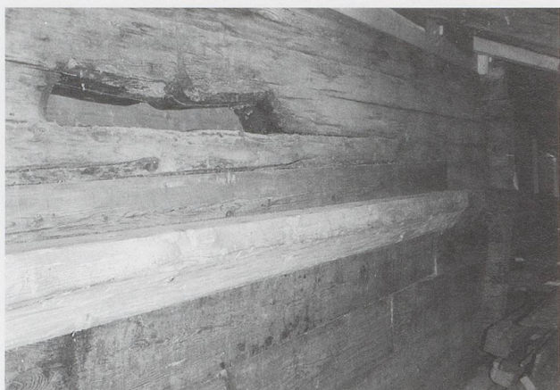
Abb. 7: Tätschdachhaus Ennetbühl, gotisches Schlitzfenster an der Ostwand. (Bild kant. Denkmalpflege)
