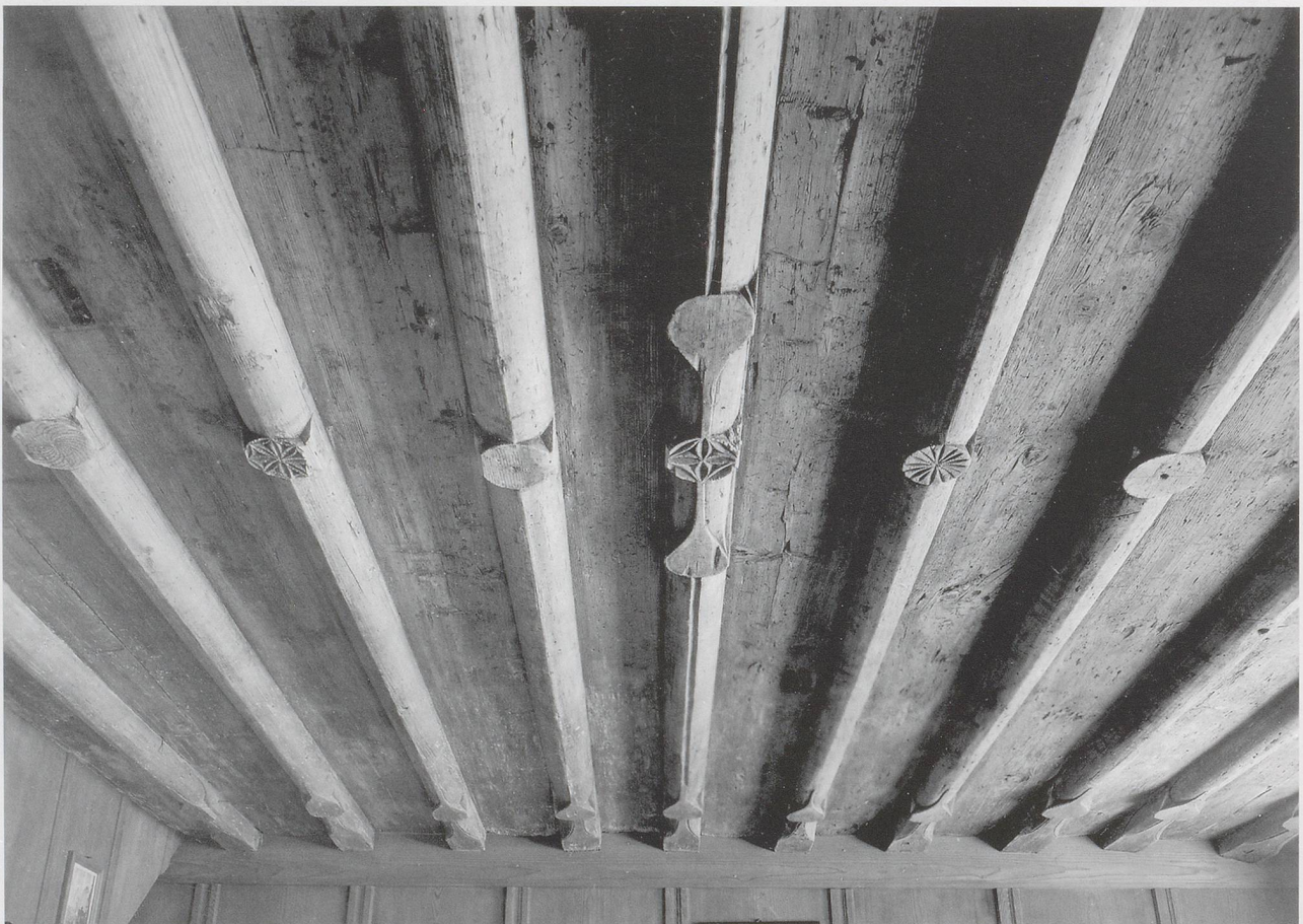
Abb. 9: Die Bohlen-Balken-Decke in der Stube des Zwinglihauses. (Bild kant. Denkmalpflege)
