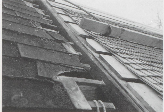
Abb. 2: Im Herbst 2006 wurde durch die Gemeinde Gaiserwald an der Spiseggbrücke die Dacheindeckung aus Eternit durch handgespaltene Holzschindeln ersetzt. Es zeigt sich, dass auch Eternit nicht ewig hält und Holzschindeln mit einer Lebensdauer von bis zu hundert Jahren durchaus konkurrenzfähig sind. (Bild kant. Denkmalpflege)
