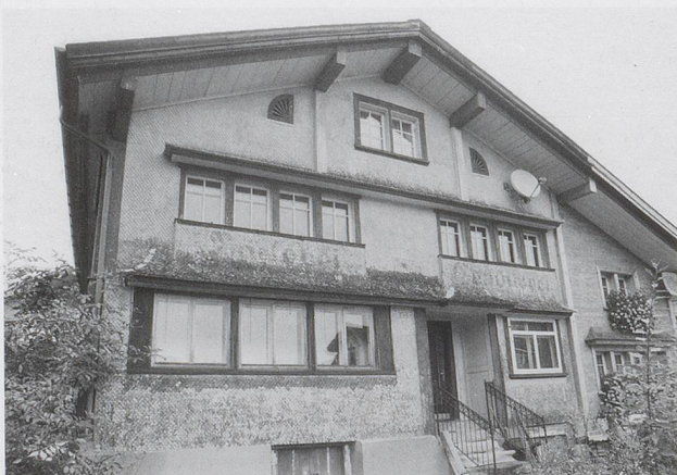
Abb. 4: Das Tätschdachhaus in Sidwald wies vor der Renovierung von 2002–03 ein Schindelkleid aus dem 19. Jahrhundert auf. Die mutmassliche Amtsstube mit den Malereien befindet sich im Obergeschoss links. (Bild kant. Denkmalpflege)
