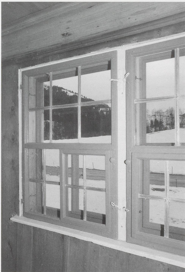
Abb. 20: Tätschdachhaus Ennetbühl, barockes Fenster mit Bleiruten als Sprossen. (Bild kant. Denkmalpflege)
