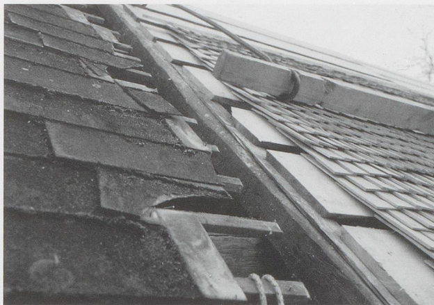
Abb. 2: Im Herbst 2006 wurde durch die Gemeinde Gaiserwald an der Spiseggbrücke die Dacheindeckung aus Eternit durch handgespaltene Holzschindeln ersetzt. Es zeigt sich, dass auch Eternit nicht ewig hält und Holzschindeln mit einer Lebensdauer von bis zu hundert Jahren durchaus konkurrenzfähig sind. (Bild kant. Denkmalpflege)
