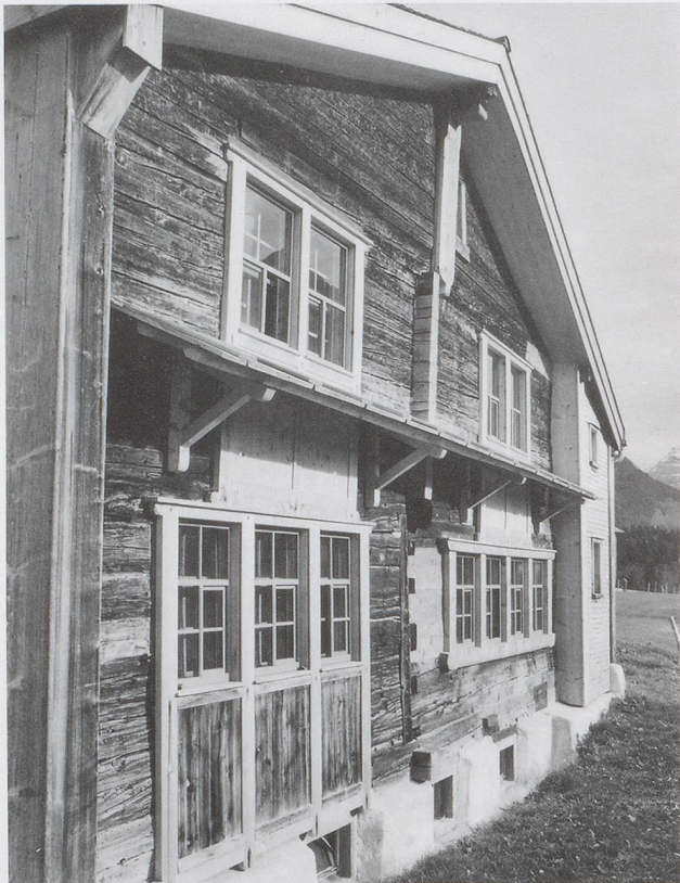
Abb. 3: Das unscheinbare Tätschdachhaus in Ennetbühl (Gemeinde Nesslau-Krummenau) wurde jahrelang vernachlässigt. Eine neue Eigentümerschaft hat das Haus umfassend renoviert und unter anderem die Fassade wieder freigelegt und mit einem Klebdach versehen. Das neue Holz zeichnet sich jetzt noch stark ab, wird sich aber bald dem Altbestand angeglichen haben. (Bild Heinrich & Verena Scherrer)
