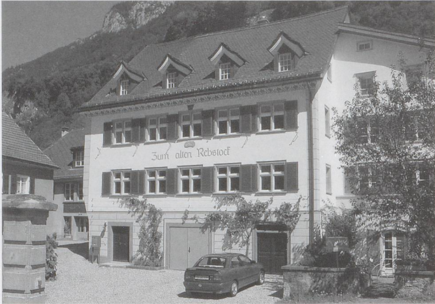
Sargans, Haus zum Alten Rebstock. Das früher bedeutende Wirtshaus liegt am ehemaligen westlichen Zugangsweg zum Städtchen, auf welchem bis ca. 1908 der ganze Verkehr nach Sargans passierte. Die Bausubstanz reicht bis mindestens ins 15. Jh. zurück, zeugt aber auch von einer bewegenden Geschichte und mehreren Umbauten und Erweiterungen. Heute tritt vor allem der stattliche Erweiterungsbau des 18. Jh. mit Satteldach und fünfachsiger Fenstergliederung in Erscheinung. (Bild Architekturbüro Wildhaber Flums)
