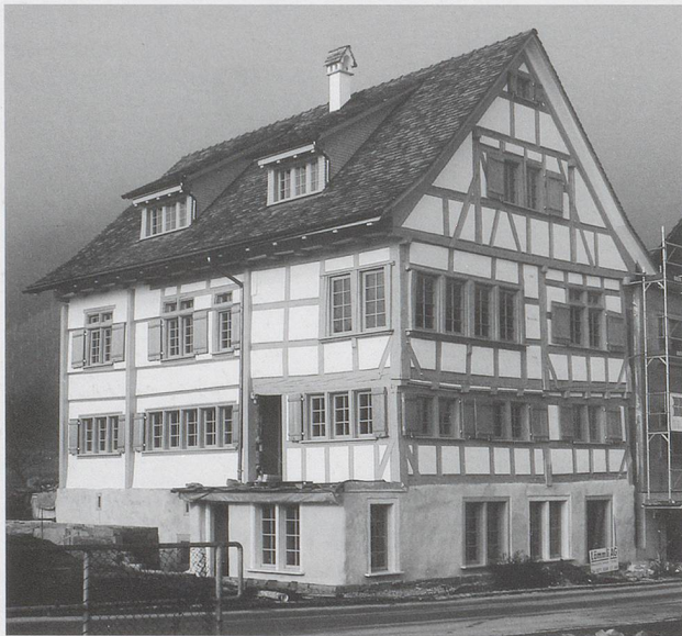
Berneck, Wohnhaus Klösterli. Das ins frühe 15. Jahrhundert zurückreichende Wohnhaus zählt zu den bedeutendsten historischen Bauten der Gemeinde Berneck. 1565 und 1586 erfolgten wesentliche Umbauten und Erweiterungen. Die äusserst sorgfältige Restaurierung zielte auf die Wiederherstellung der Erscheinung von 1586 – damals hatte der einst bescheidene Strickbau zusätzliche Repräsentationsräume und ein stattliches Äusseres erhalten. Der moderne Anbau beherbergt die neuzeitlichen Service-Bereiche und gestattet eine möglichst unbehelligte Wohnnutzung der historischen Räume. (Bild Josef Geier St. Gallen)
