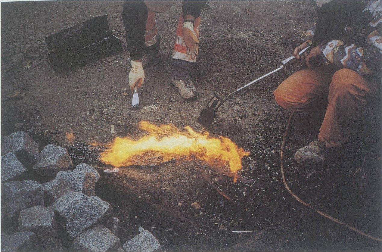
Abb. 2: Der Teer in der Bleibox von Waldkirch wird aufgeschmolzen.
