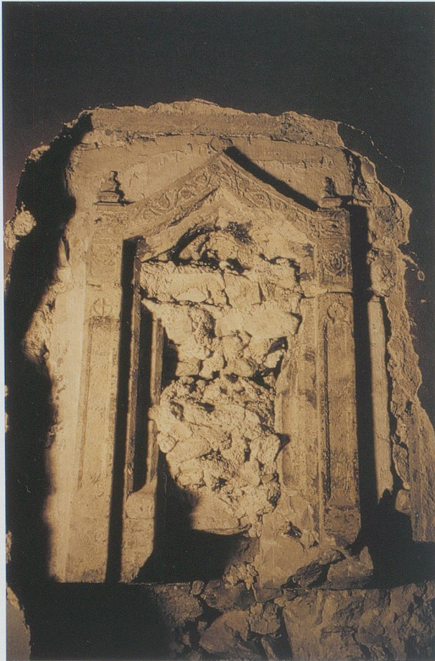
Abb. 17: Jona, Pfarrkirche. Sakramentsnische bei der Auffindung und nach der Restaurierung. (Bild KASG)
