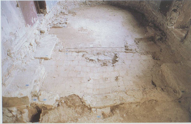
Abb. 9: Jona, Pfarrkirche. Mörtelboden mit Tonplattennegativen der zweiten Kirche, Blick gegen Osten. (Bild IGA)
