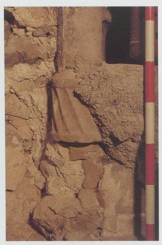
Abb. 13: Jona, Pfarrkirche. Verziertes unteres Ende der massiven Spindel der Wendeltreppe. Um 1438. (Bild KASG)
