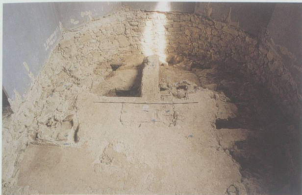
Abb. 5: Jona, Pfarrkirche. Blick gegen Osten auf den Chor und Vorchorbereich der karolingischen Kirche mit rotem Mörtelboden und Altar. (Bild IGA)
