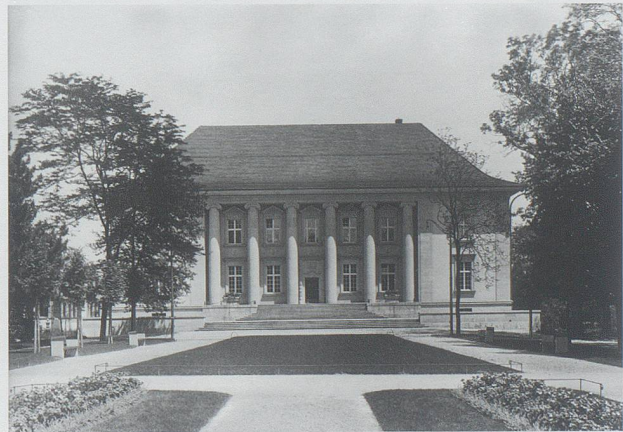
Abb. 2: Das 1921 erbaute «Neue Museum im Stadtpark». (Bild HMSG)
