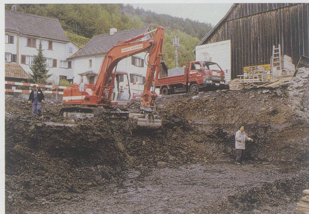
Abb. 20: Verlust von Geschichte: Der Bagger zerstört innert Stunden die Quellen zu 2000 Jahren Geschichte. Wartau-Azmoos, Überbauung Löwen Azmoos. Maja Suennderhauf, Konservatorin Regionalmuseum Schlagenhaus Werdenberg bei der Notdokumentation von frühmittelalterlichen Siedlungsresten. (Bild KASG)
