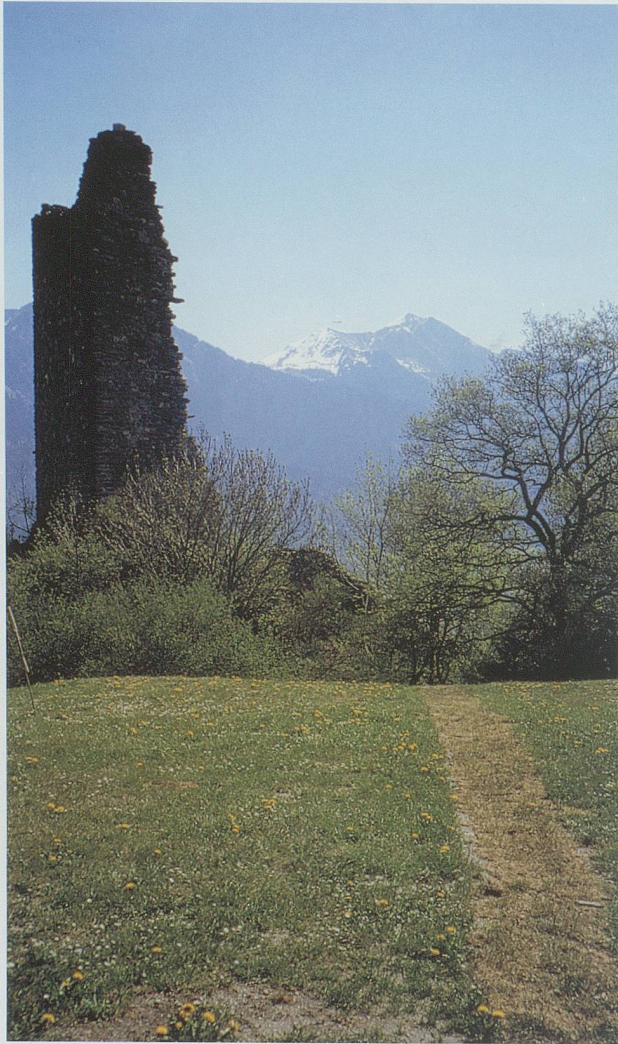
Abb. 14: Gut gemeint. Schlecht gemacht. Baggerschlitz auf der Ruine Freudenberg bei Bad Ragaz: Hier wäre 2003 eine archäologische Begleitung zwingend notwendig gewesen! Der Graben ist bereits geschlossen (heller Streifen rechts). (Bild KASG)
