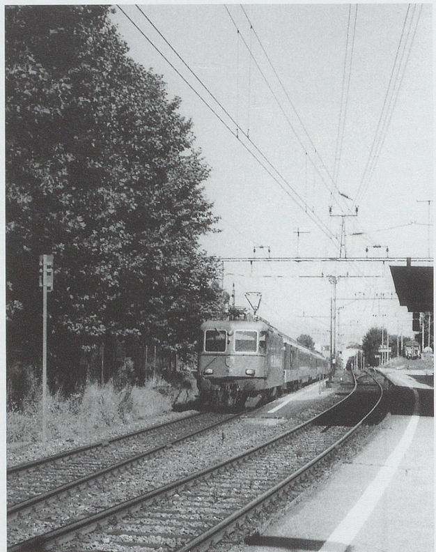
Die Gefällsverhältnisse des Kreuzungsgleises weisen noch heute auf den erst nachträglichen Bau der Goldacher Stationsanlagen hin. (Foto A. Heer)
