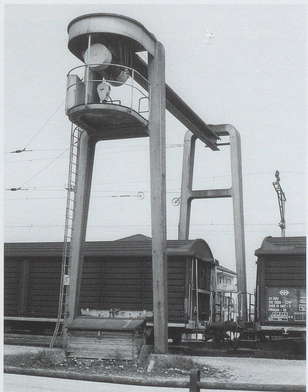
Einer der von H. Hilfiker entworfenen, zeitlos erscheinenden Portalkrane wurde im Frühjahr 2004 in Goldach SG aufgenommen. (Foto A. Heer)
