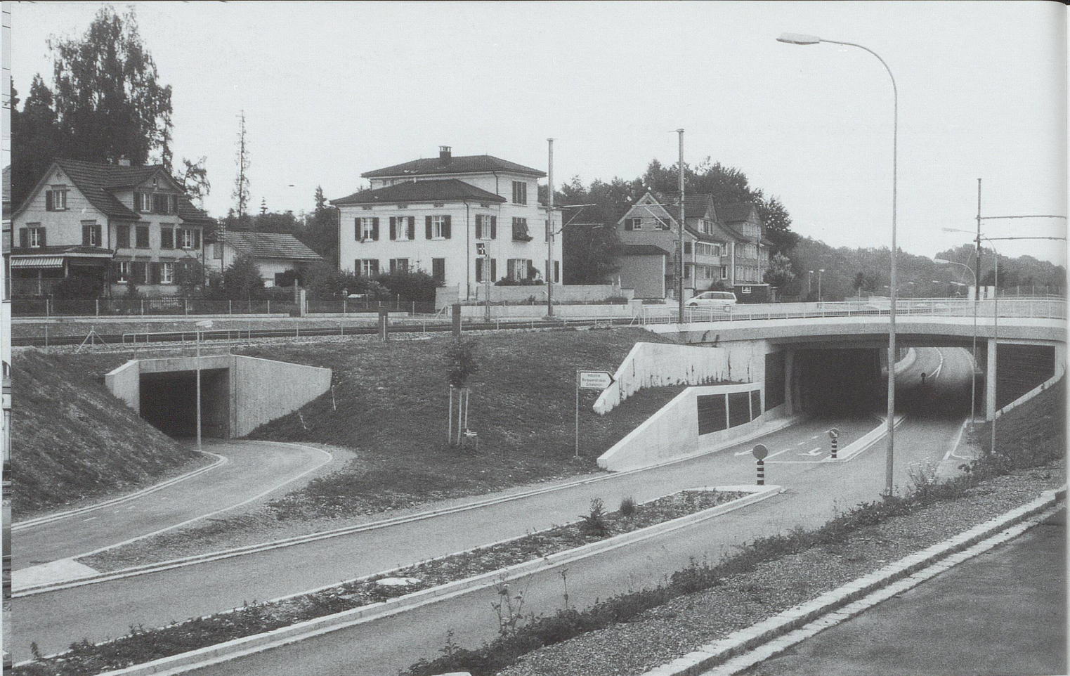
Im Jahre 2001 wurde die seit 80 Jahren diskutierte Entflechtung zwischen Schiene und Strasse in Flawil SG durch die grosszügige Unterführung Feld Wirklichkeit. (Foto A. Heer)
