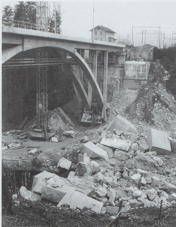
Das Trümmerfeld nach der Sprengung des alten Glatt-Viadukts vom 26. Januar 1997. (Foto A. Heer)
