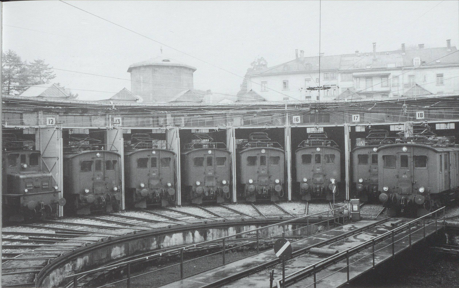
Das Lokomotivdepot St. Gallen im Frühjahr 1977. (Foto D. Heer)
