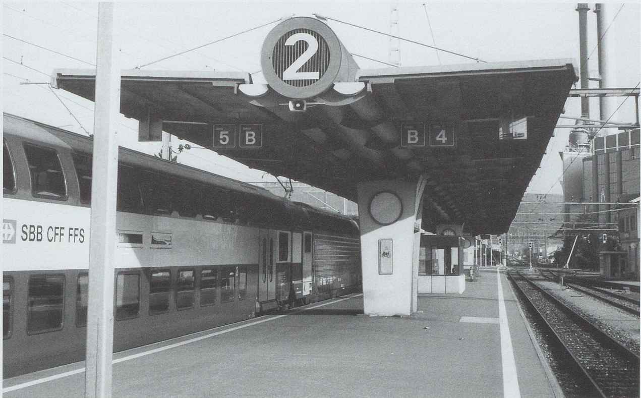
Die von H. Hilfiker konstruierten Perrondächer von Winterthur-Grüze. (Foto A. Heer)
