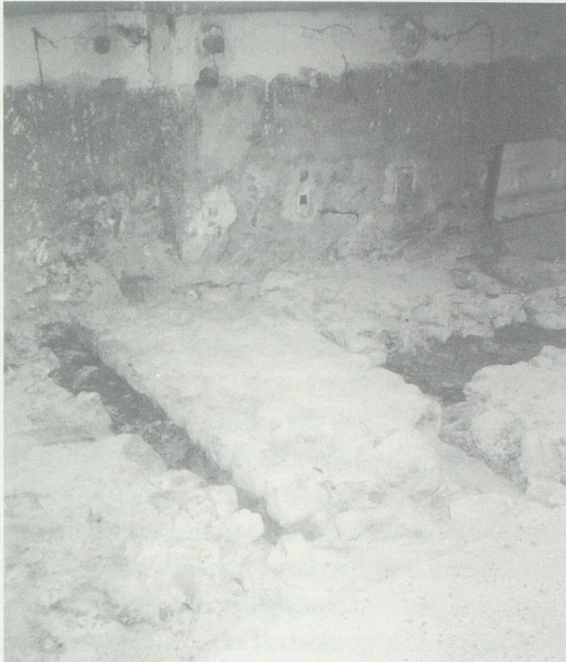
Schänis, Kirche St. Sebastian. Blick ins nördliche Seitenschiff nach dem Entfernen der Bänke. Gut sichtbar die ehemalige Westmauer (bis 1910), beidseitig das eingebrachte Steinbett. Dahinter die Betonunterfangung von 1975. Foto KASG.
