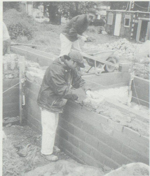
Jona, Kempraten. Aufmauerungsarbeiten. Gut sichtbar ist der Aufbau: Auf das durch eine Lehmschicht geschützte Originalmauerwerk folgt zuerst eine Zementsteinmauer, darauf dann die später sichtbare Bruchsteinmauer. Im Vordergrund Antonio De Cristofaro, hinten Raphael Schwyter. Foto KASG.
