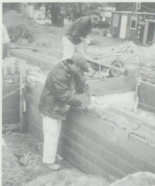
Jona, Kempraten. Aufmauerungsarbeiten. Gut sichtbar ist der Aufbau: Auf das durch eine Lehmsschicht geschützte Originalmauerwerk folgt zuerst eine Zementsteinmauer, darauf dann die später sichtbare Bruchsteinmauer. Im Vordergrund Antonio De Cristofaro, hinten Raphael Schwyter. Foto KASG.
