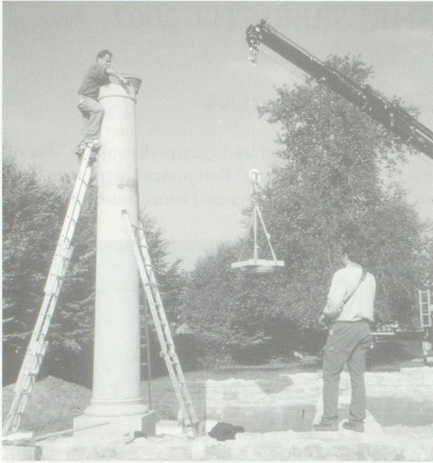
Jona, Kempraten. Der grosse Moment: Das Kapitell wird auf die 5,5 m hohe Säule aufgesetzt. Alles klappt bestens! Foto KASG.
