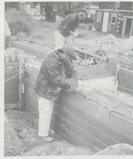
Jona, Kempraten. Aufmauerungsarbeiten. Gut sichtbar ist der Aufbau: Auf das durch eine Lehmschicht geschützte Originalmauerwerk folgt zuerst eine Zementsteinmauer, darauf dann die später sichtbare Bruchsteinmauer. Im Vordergrund Antonio De Cristofaro, hinten Raphael Schwyter. Foto KASG.
