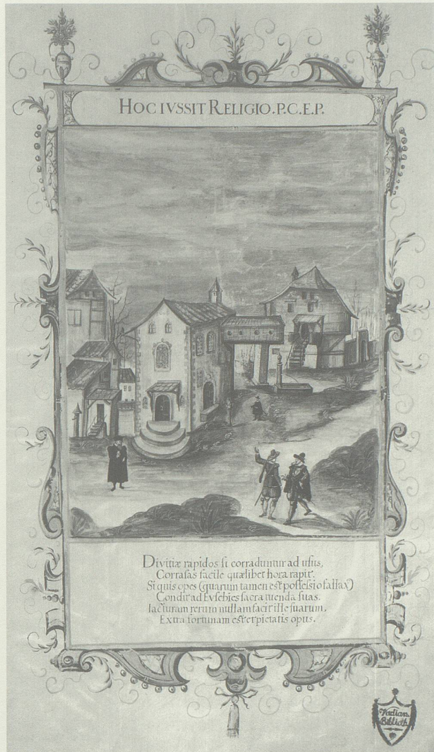
Alte Linsebühlkirche, links das Presten- oder Krankenhaus, rechts das Siechenhaus, das durch einen gedeckten Gang über die Strasse direkt mit der Kirchenempore verbunden war. Aquarell eines unbekanntes Malers, 45 x 28,5 cm. Kantonsbibliothek (Vadiana) St.Gallen.
