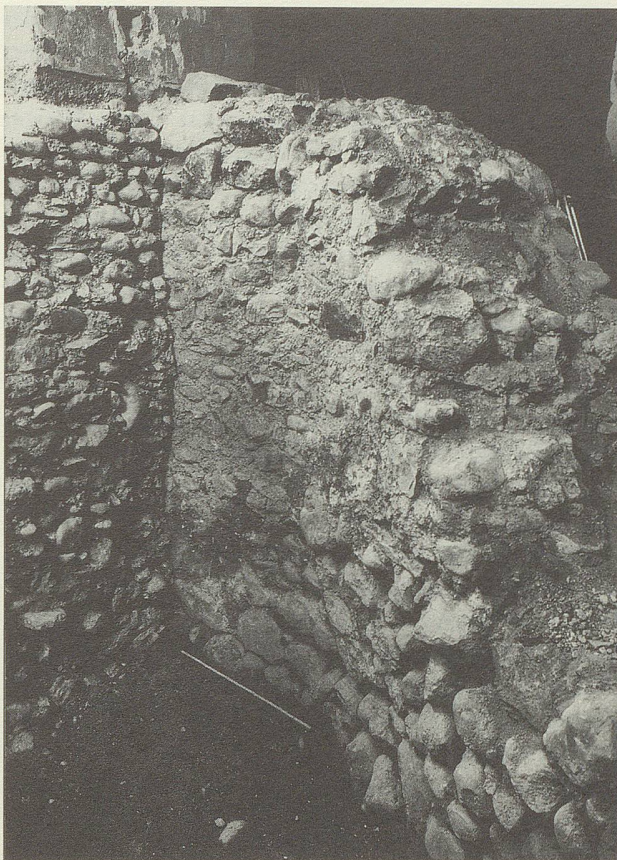
Wil, Hof: Fragment der ältesten Stadtmauer in der «Toggenburg».
