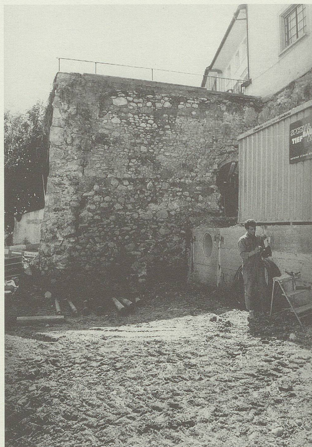
Wil, Hof: Stützmauer an der Konstanzerstrasse.
