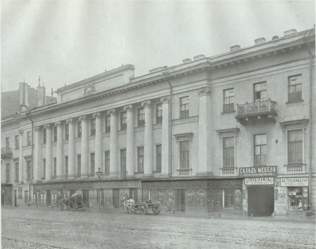
Bauten von Bernhard Simon: Haus des Fürsten Golitzin in der Wladimirstrasse.
