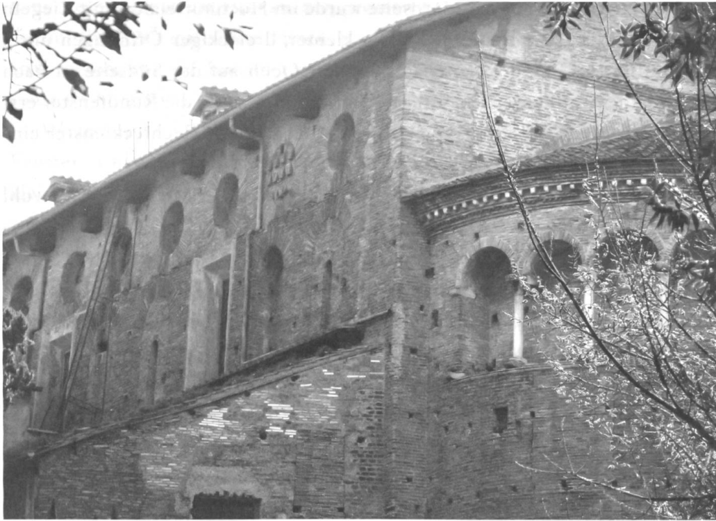
Abb. 3: Santi Giovanni e Paolo, Rom, mittelalterliches Fenster am nördlichen Obergaden (Photographie Daniela Mondini 2007)
