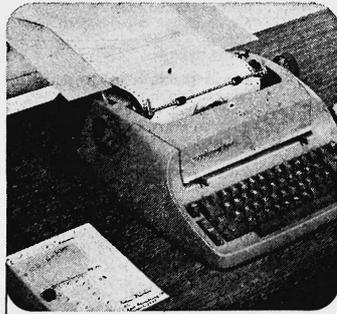
Der maschinenlesbare Schreibauftrag ruft die gewünschten Texte vom Magnetbandspeicher ab. Blitzschnell, mit über 1,2 Millionen Zeichen/min erfolgt die Selektionsansteuerung.
