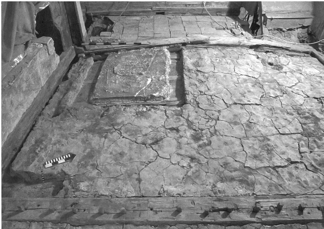
Abb. 4: Haus St.-Oswalds-Gasse 10, Zug. Bei der Bauuntersuchung wurde der Bretterboden geöffnet. Darunter kam der originale Lehmestrich zum Vorschein, in dem sich das Negativ des primären Ofenfundaments abzeichnete. Auf dem Estrich lagerten zahlreiche Lederschnipsel, Münzen und andere Funde. Quelle: Amt für Denkmalpflege und Archäologie Zug, Direktion des Innern (Markus Bolli).
