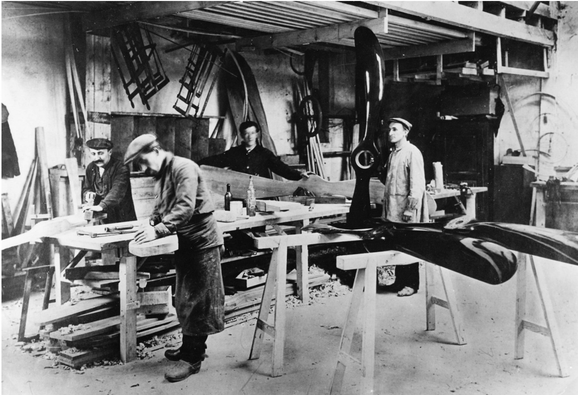
Fig. 1: Atelier de fabrication des hélices Dufaux à Genève en 1910. Photo: Archives du Musée Suisse des transports, Lucerne.
