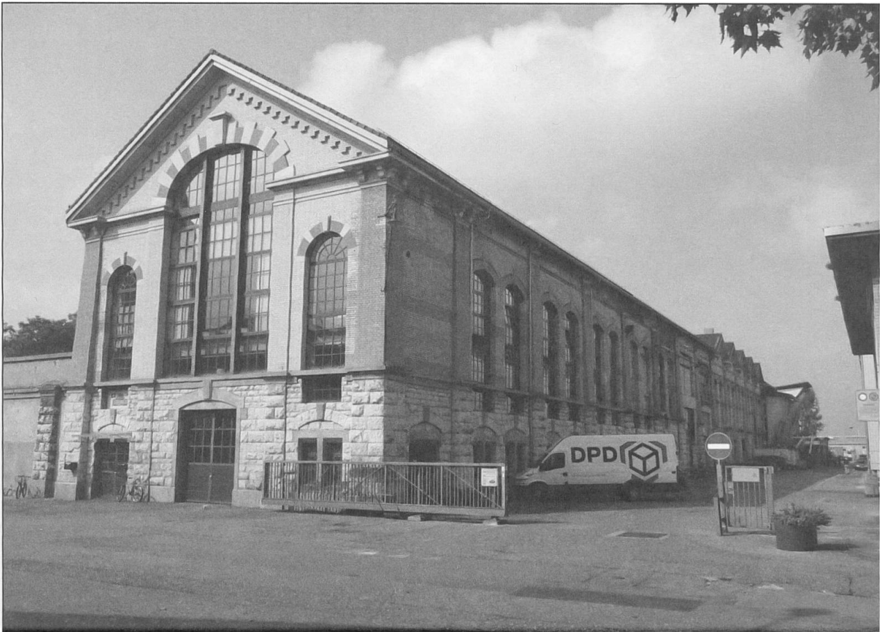
Schlieren, neugenutztes Fabrikgebäude der ehemaligen Gasfabrik. Am hinteren Ende des Gebäudes ist die Outdoor-Kletterwand des Kletterparks zu sehen (Foto: F. Roesch).
