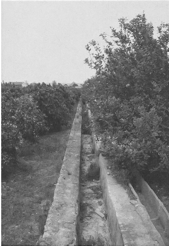
Alte Form des offenen Bewässerungskanals, bei dem die ganze Pflanzung überschwemmt wird.
