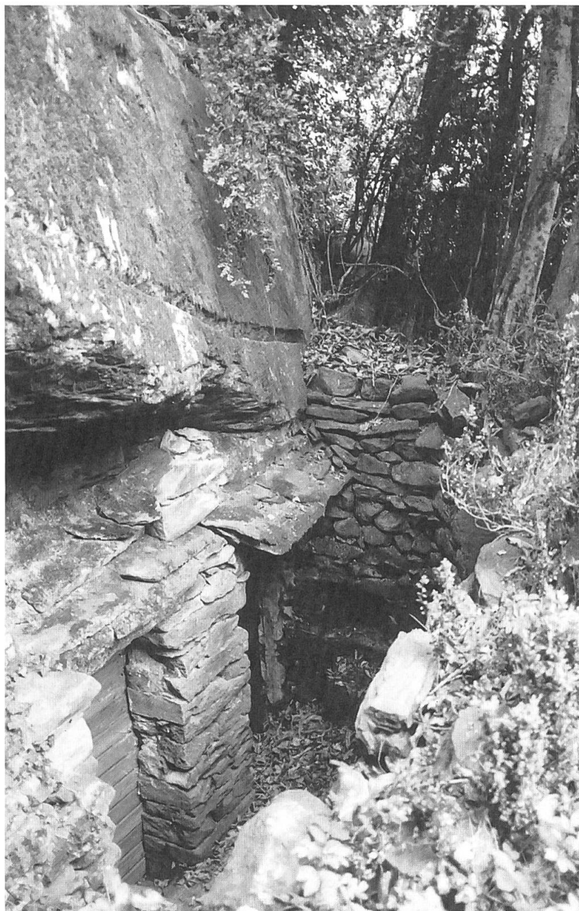
Questa foto, sulla quale vediamo due delle cantine sotto il Bàlom di Ciapitt ad Avegno, ci mostra bene la sprèola, una delle soluzioni adottate per evitare l'infiltrazione dell'acqua piovana che scorre lungo il macigno nell'interno della cantina.
