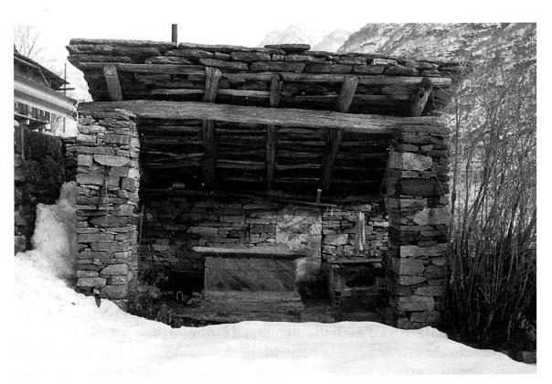
Fig. 5: Lavatoio a Brione Verz.; a destra il fornello per la caldaia o la lessivôs...
