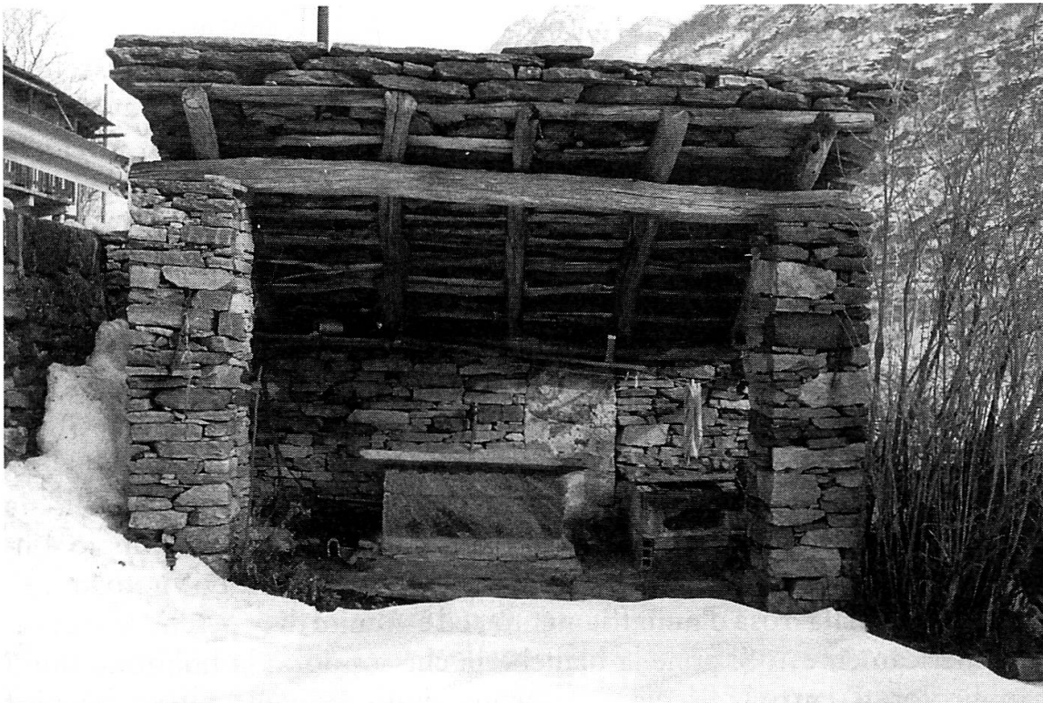
Fig. 5: Lavatoio a Brione Verz.; a destra il fornello per la caldaia o la lessivòs ...
