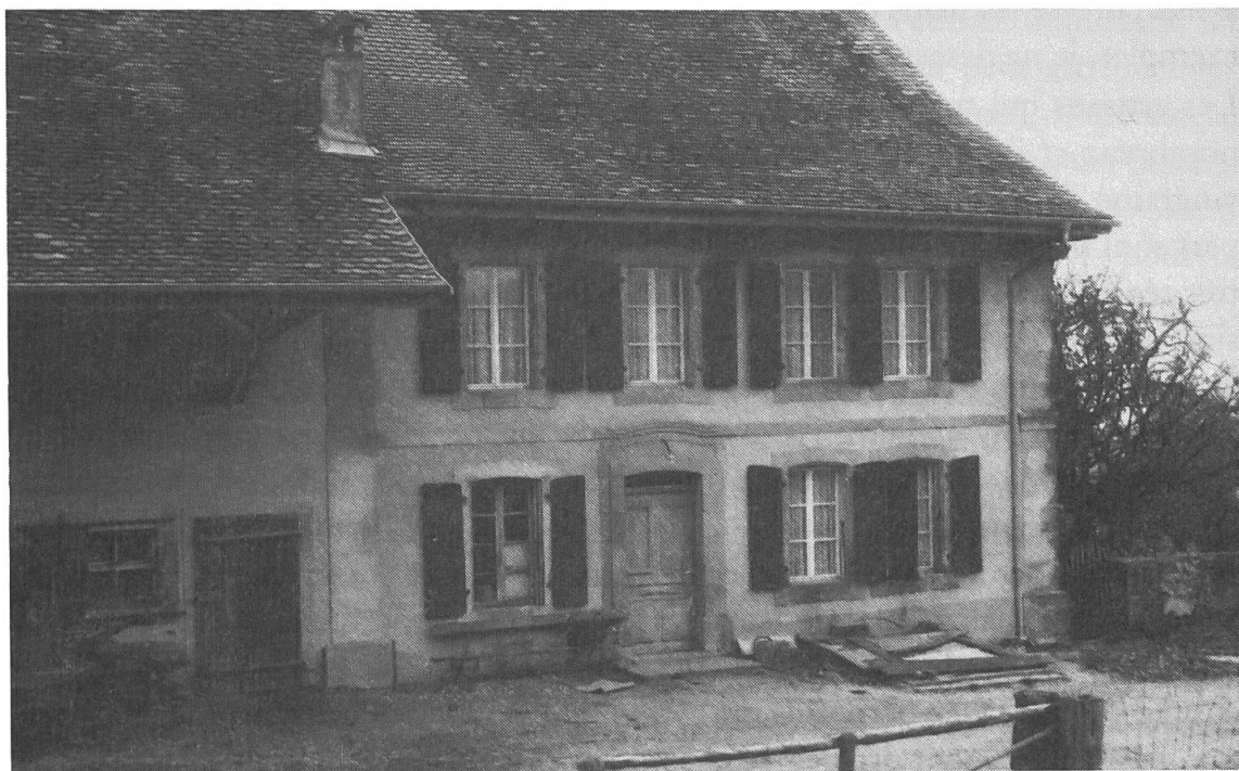
Fig. 11 Pailly (cad. 163), maison paysanne de 1794, maçon Isaac Buloz; les deux niveaux du logement sont séparés par un bandeau, qui s'enrichit d'une corniche au-dessus de la porte d'entrée.
