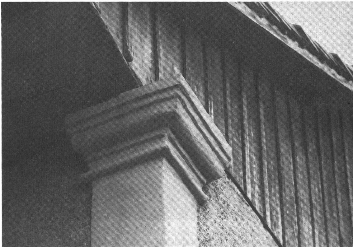
Fig. 9 Hameau d'Epautheyres, commune d'Essertines-sur-Yverdon (cad. 106); chapiteau de 1828 que l'on peut rapprocher de l'ordre toscan (astragale, gorgerin nu, filet, échine et tailloir).
