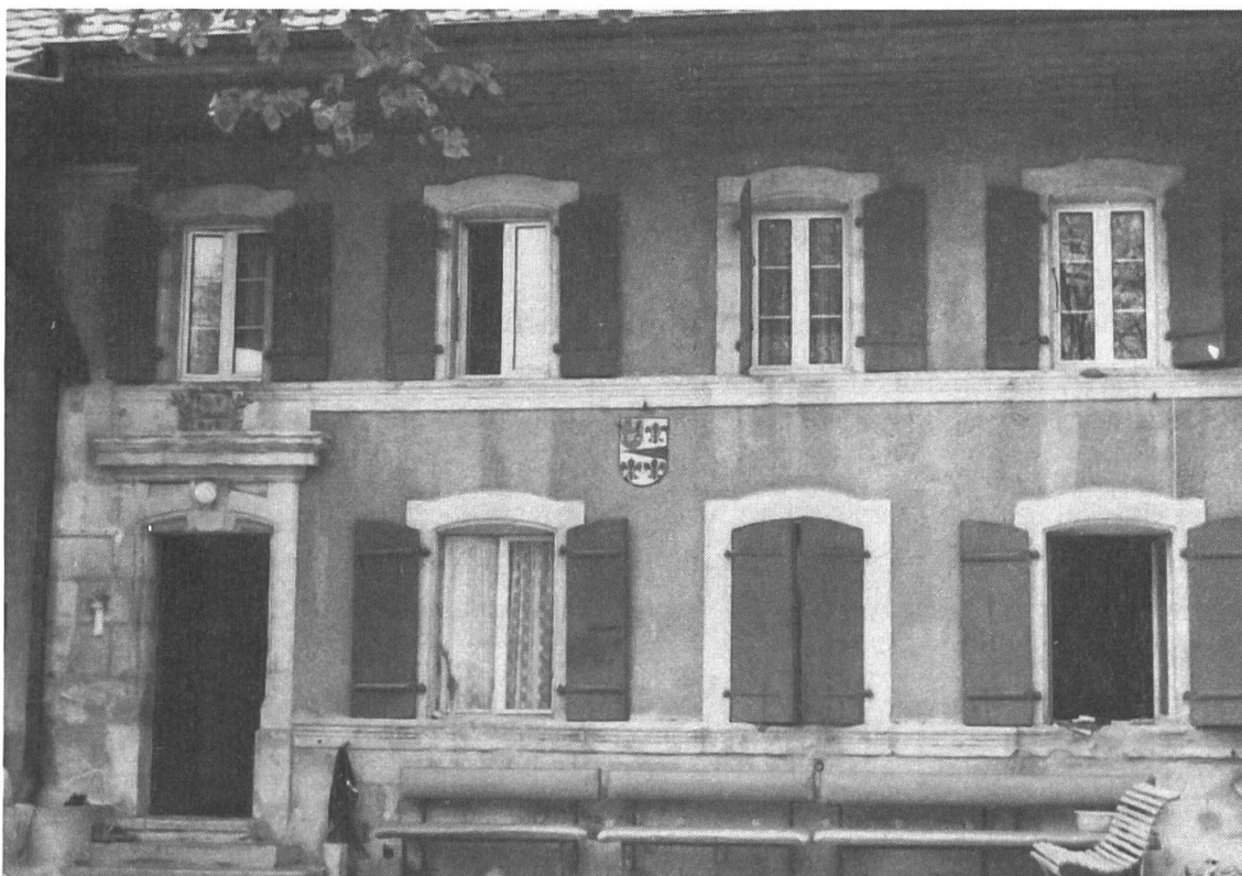
Fig. 4 Bioley-Orjulaz (cad. 148), logement de 1818 environ; la porte d'entrée est mise en valeur par un encadrement mouluré, une clé saillante, une corniche et un dessus de porte, orné des armoiries familiales du propriétaire. A noter encore la présence d'un soubassement en pierre appareillée, de deux cordons et le fait que les fenêtres du rez-de-chaussée sont plus élancées que celles de l'étage.
