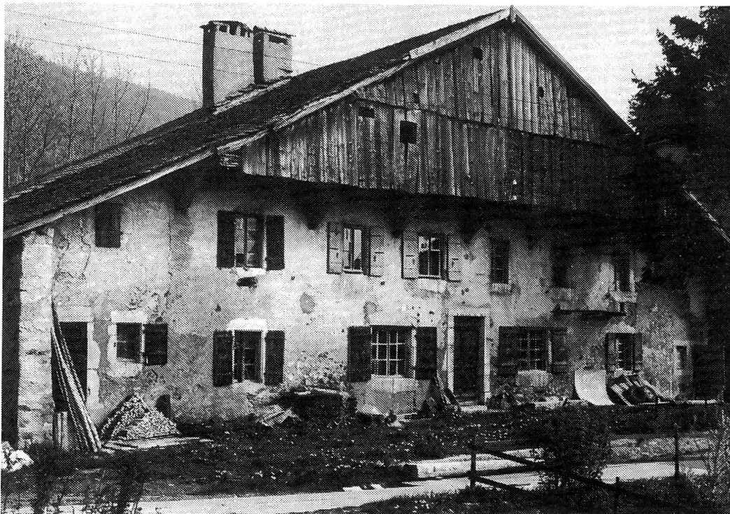
Provence. Ferme à pignons frontaux . Propriété M. Gaille. – On notera les deux portes donnant accès aux écuries (étables à vaches) aux extrémités de la façade. L'accès aux deux logements du rez se fait par une porte et un couloir central.
