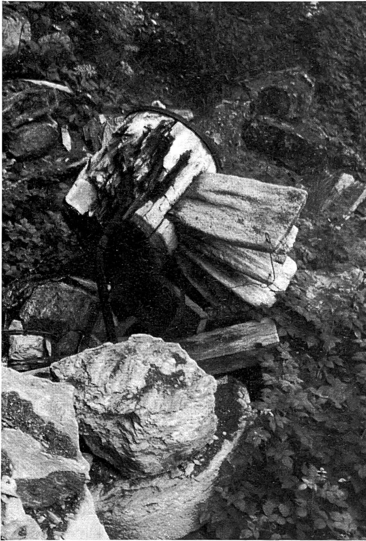
Fig. 10. Chandolin, août 1979. – Les vestiges du moulin sont saccagés, l'axe de fer, tordu, dresse l'an- cienne roue horizontale au-dessus des pierres, comme une fleur fanée
