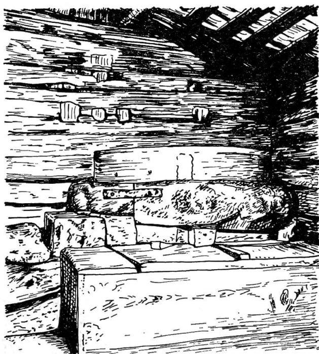
Fig. 3. Chandolin, août 1975. Intérieur du premier moulin. La meule tournante est cachée par un couvercle de bois. Au premier plan, la huche à farine. La trémie a été «prélevée» par un antiquaire
