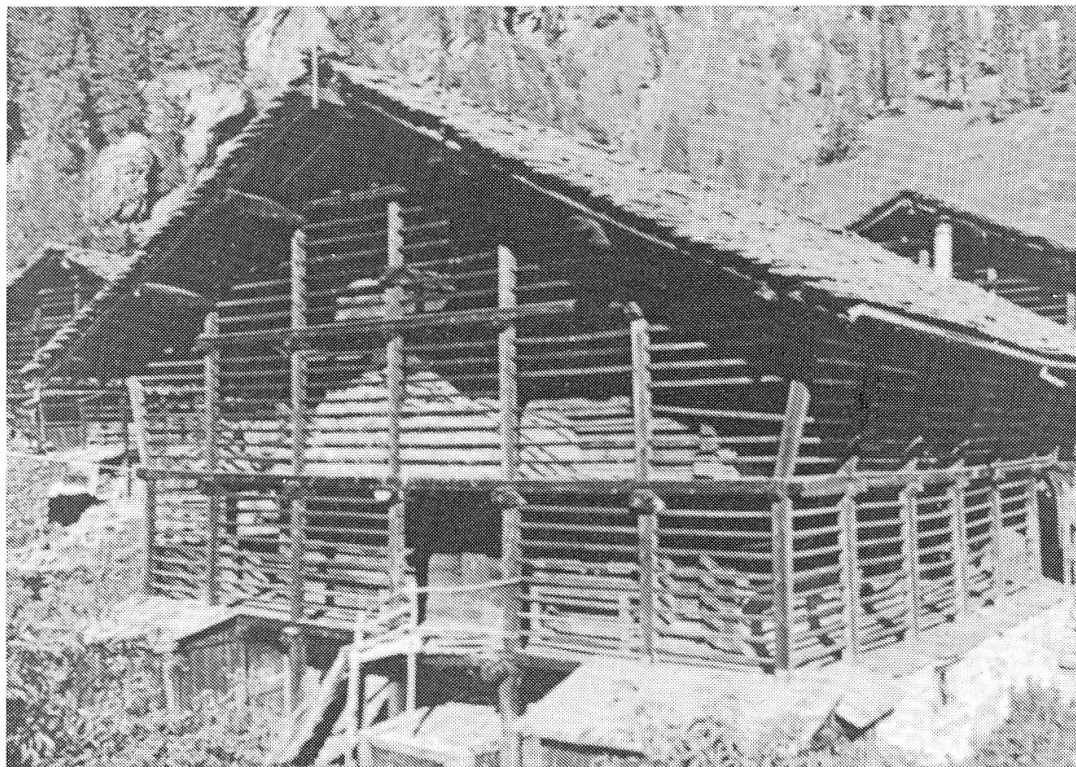
Ancienne maison d'Alagna entourée des galeries qui servent de séchoir. La maison n'a pas de cheminée.
