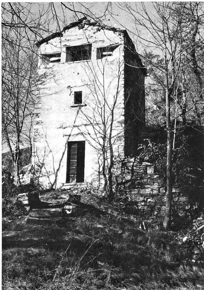
◀ Fig. 51. Scudellate , m. 950 s.M. Costruzione massiccia che poggia diretta- mente sulla roccia.
