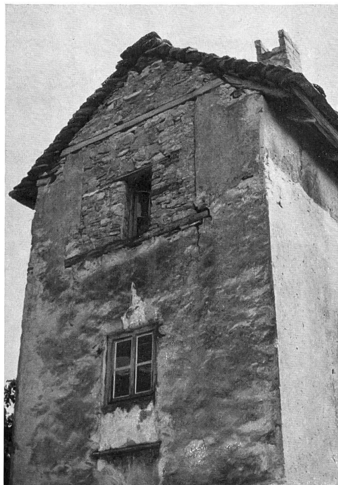
Figg. 3 e 4. Sementina (Vignascia) m. 223 s. M. Il rustico porta la data 1776 e venne addossato al casello che esisteva già. Nella fotografia si vede chiaramente la grande apertura ret- tangolare che venne più tardi murata in parte per formarne una più piccola.
