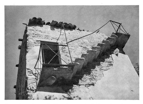
Fig. 25. Barbengo I. Dettaglio della scala esterna che dall'ultimo piano sale al tetto.
