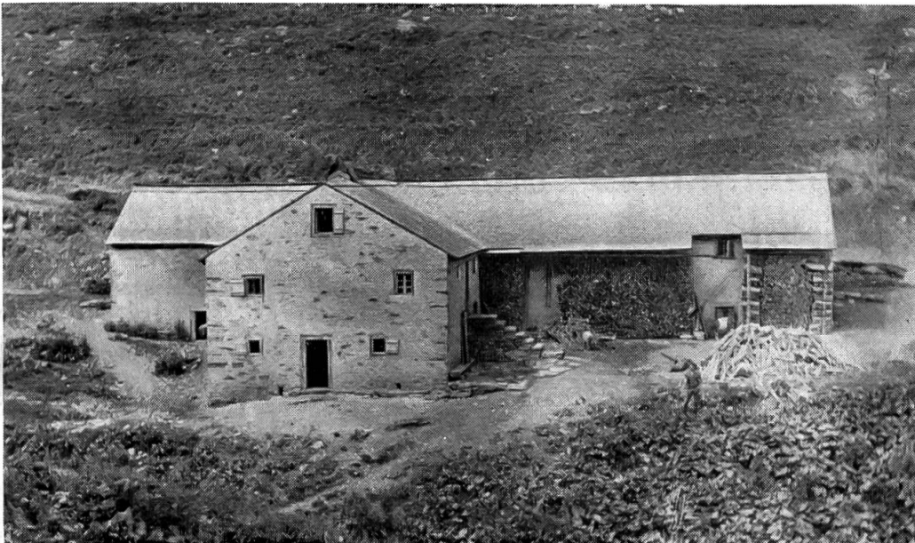
Fig. 2. Le chalet de Sazième: construction de pierre, à trois étages, en forme de T.
