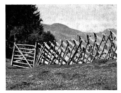
Fig. 8. Ancienne clôture de pâturage («haie en matière»), faite de branches de sapin servant de pieux et de lattes refendues à la hache. A gauche: portillon à claire-voie («clédar»). Château-d'Œx.
