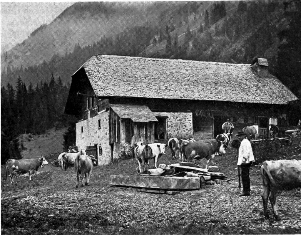
Fig. 1. Le chalet du Pâquier Mottier (train de Sazième): ancienne construction de pierre et de bois, qui a subi des transformations ultérieures. La disposition des locaux ne correspond pas exactement à celle, plus fréquente, qui est décrite dans le texte p. 17*; remarquer néanmoins les différences, typiques, entre fig. 1 et fig. 2.
