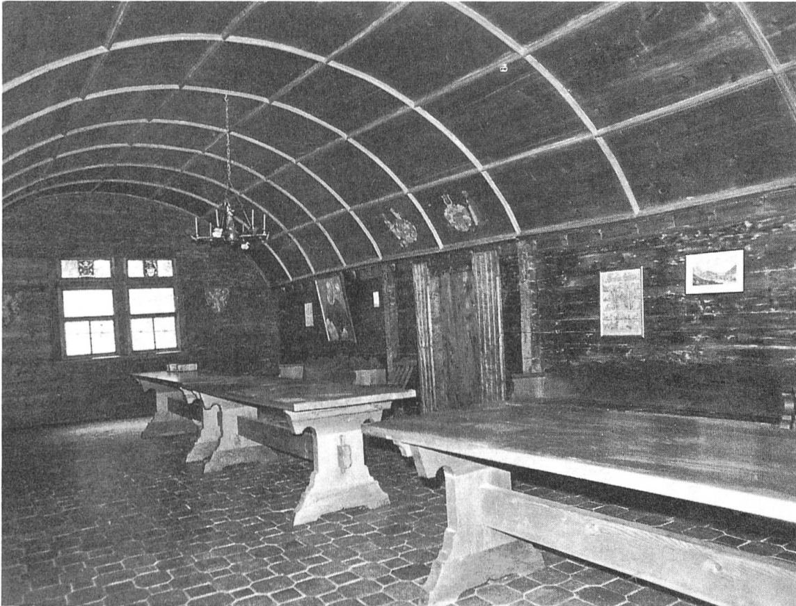
Abb. 3. Der Firstsaal mit dem Tonnengewölbe und dem Fliesenboden.
