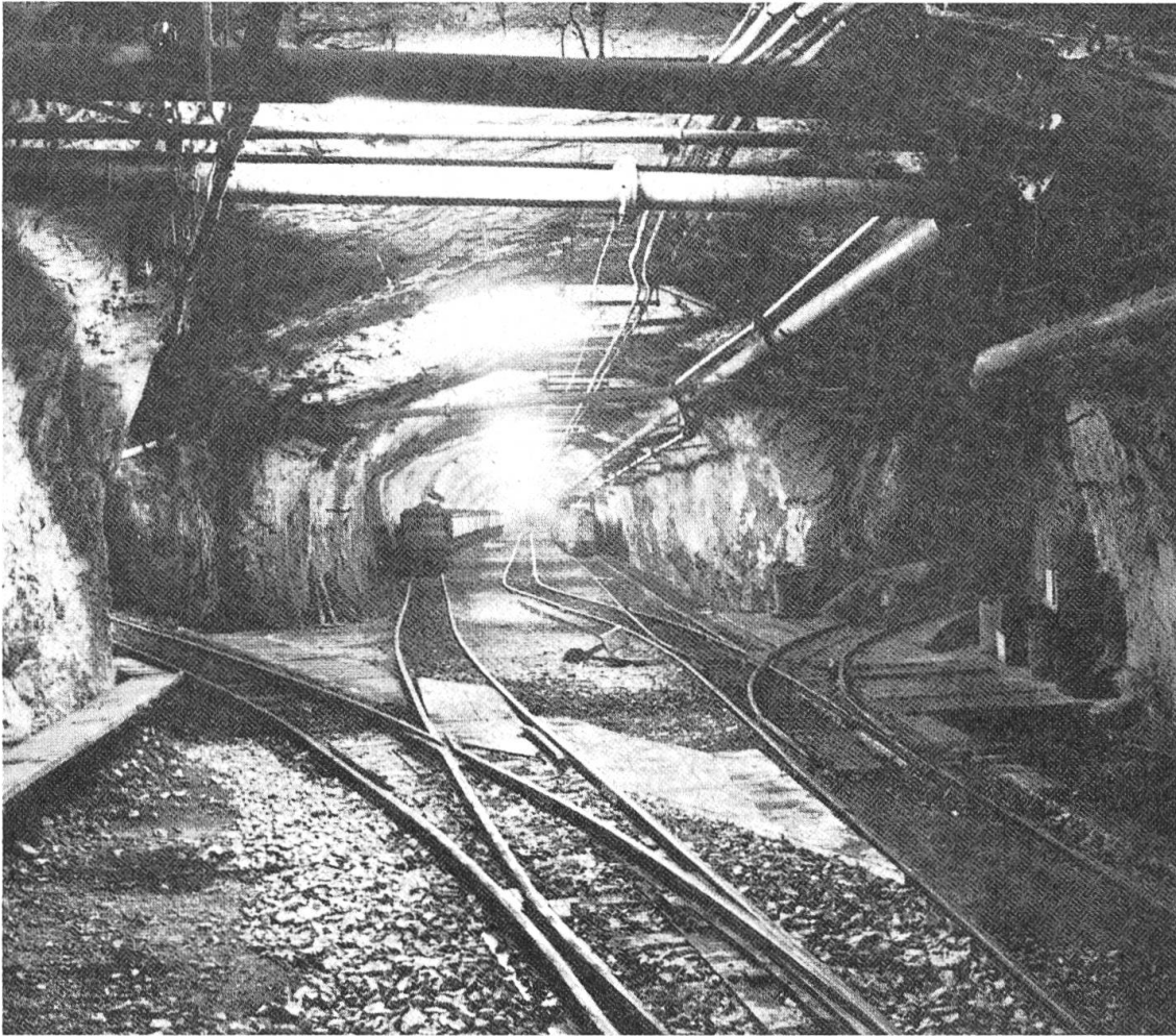
Basisstollen-Bahnhof. Blick nach Norden. Mitte links: Erzzug beim Verladen. Rechts: Abzweigung zum Steillager und zum Fluhwandgesenk. Links Abzweigung zu Kompressorenhalle, Werkstätte, Sprengstoffmagazin und zu Silos von zwei Bremsbergen. Aufnahme ca. 1965. Foto aus W. Epprecht, 2000 Jahre Eisenbergwerk Gonzen Sargans. Pro Gonzenbergwerk. Sargans 1987.
