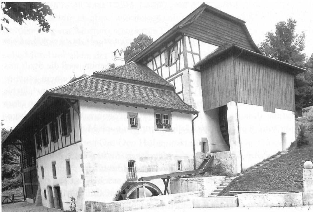
Die Alte Stadtmühle von Westen her. Das obere Wasserrad ist im Anbau untergebracht und daher nicht sichtbar (Foto: A. Buchs)
