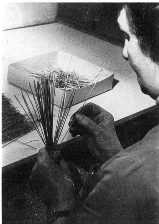
Abb. 3. Heimarbeiterinnen und Hilfskräfte in der Fabrik bereiten die Mundstücke vor: Alfagrashalme (paglia) in die Stohhalme (cannuccio) stecken.
