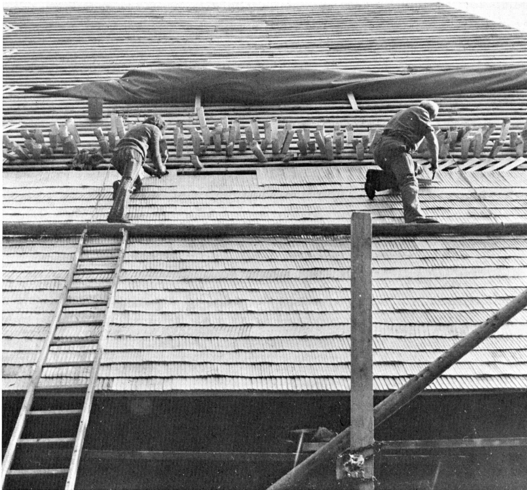
Das Haus von Madiswil erhält ein Schindeldach.
